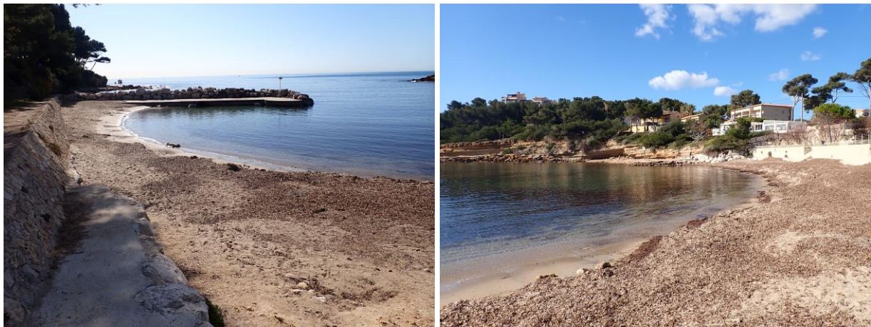
Figure 3 : Photographies de la plage, à gauche : digue en partie Est ; à droite : vue vers l'Est (Galatea, 2022)
