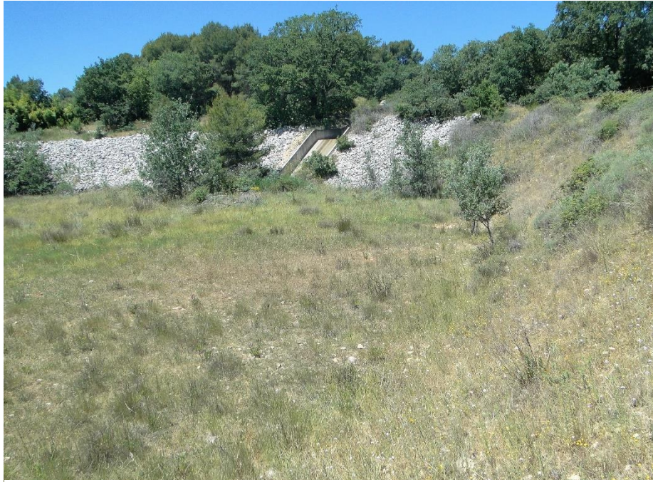
Principale végétation sur le site, prairie dans le collecteur d'eau (Source : A. COACHE)
