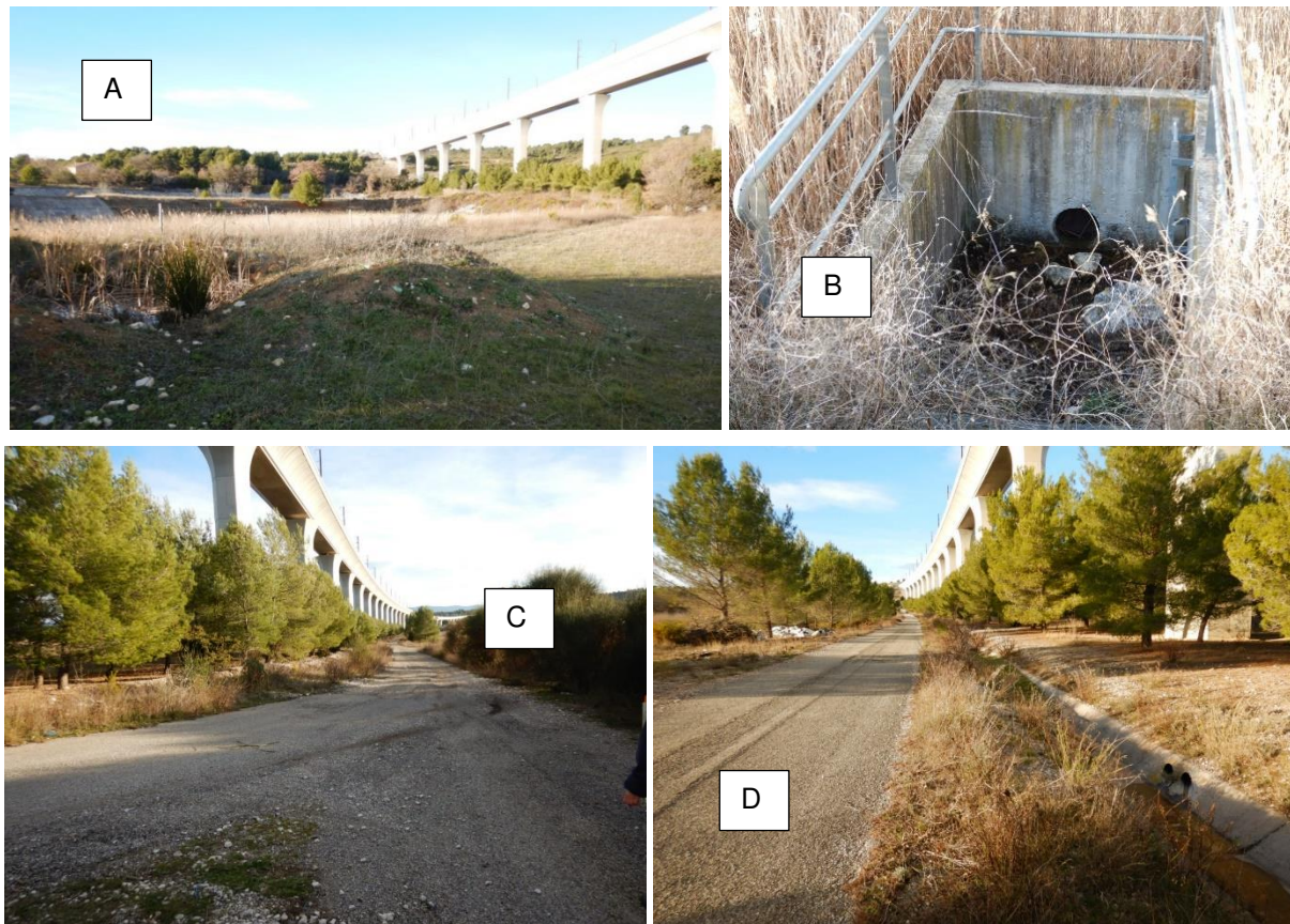
Figure 7 : Au droit de la zone d'étude : vue des bassins de rétention depuis l'aval (A), exutoire des bassins pour le débit de fuite (B), vue amont du chemin SNCF avec le fossé du BV Est à gauche (C), vue aval du chemin SNCF avec le fossé du BV Est à droite (D)
