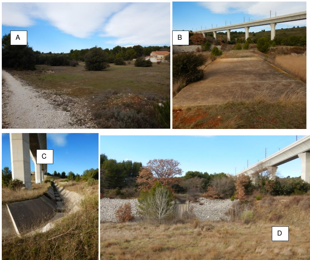
Figure 6 : Amont de la zone d'étude : arrivée du bassin versant intercepté par le projet – vue aval (A), bassins de rétention et surverse intermédiaire (B), réseau pluvial de l'infrastructure TGV (C), rejet de ce dernier dans les bassins de rétention (D)
