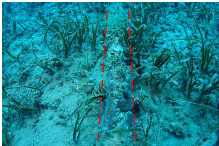
*Figure 62 : Câble de transport d'énergie SACO12 en limite inférieure de l'herbier entièrement colonisé (Bastia - plage de l'Arinella, 2020)*
