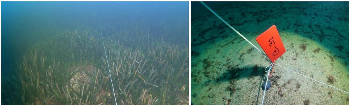
Figure 5 : Filin lesté sur le fond marquant le tracé du câble sous-marin
