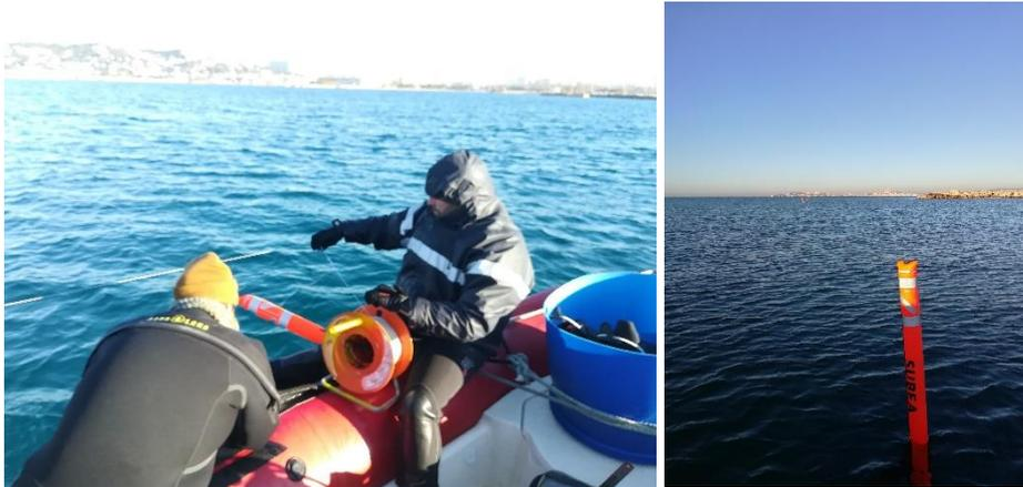
Figure 4 : Installation des balises le long du tracé du câble
