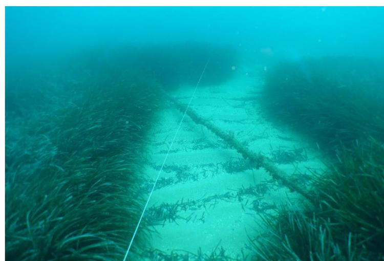
Figure 69 : Câble télécom en suspension au passage d'une zone d'intermatte (Marseille, 2020)
