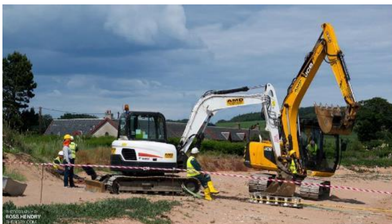
Figure 16 : Opération de tirage de câble avec deux pelleteuses et un quadrant (source : Orange Marine)
