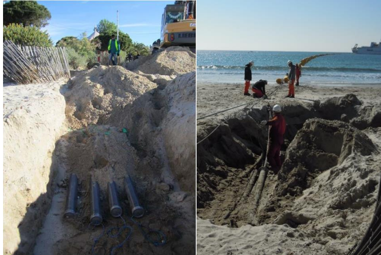
Figure 5 : Illustration de l'installation de conduites d'accueil en haut de plage (à gauche), puis de conduites dégagées à l'occasion de travaux préparatoires à la réception d'un câble (à droite)
