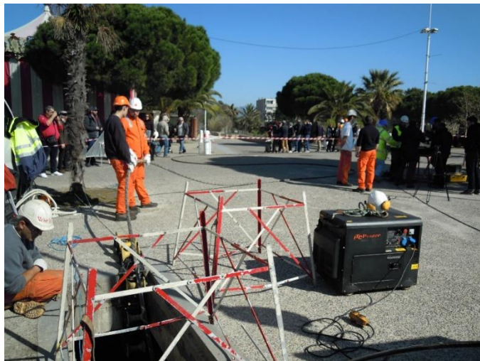
Figure 20 : Tirage du câble en dehors de la chambre plage avant raccordement
