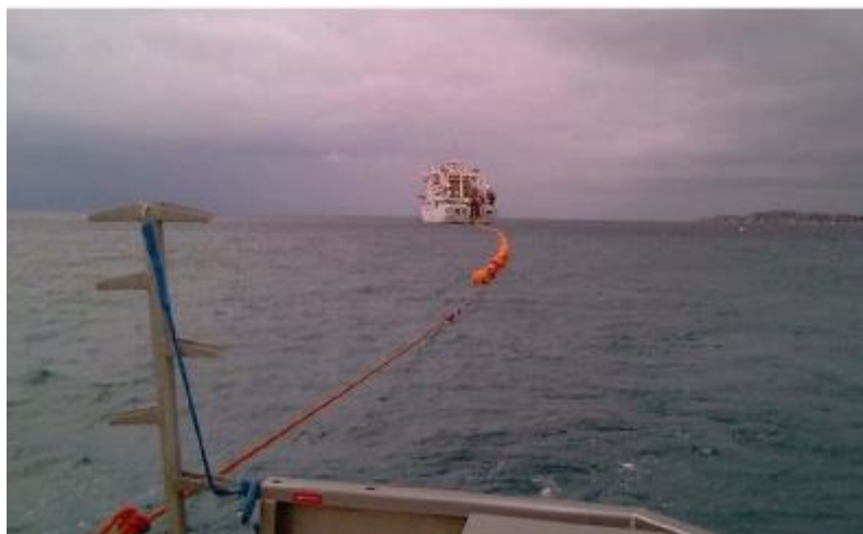
Figure 15 : Exemple de tirage d'un câble depuis un navire câblé vers la plage (source : Orange Marine)
