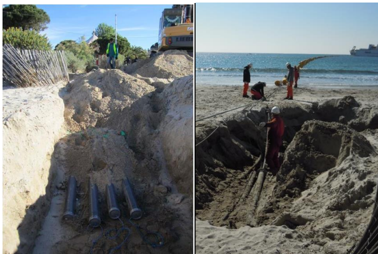
Figure 8 : Illustration de l'installation de conduites d'accueil en haut de plage (à gauche), puis de conduites dégagées à l'occasion de travaux préparatoires à la réception d'un câble (à droite)
