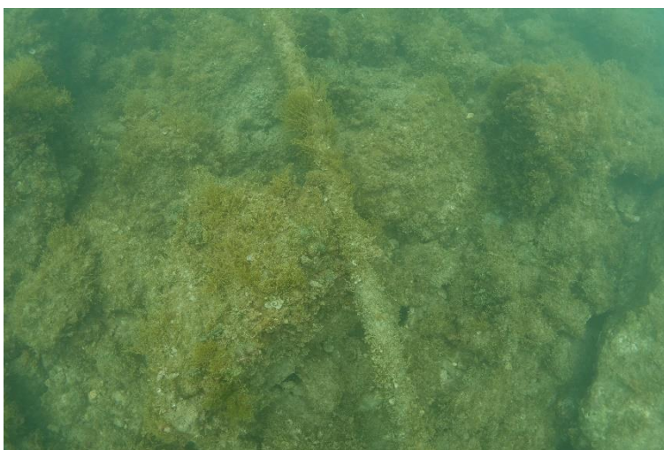
Figure 77 : Câble télécom sur des enrochements (Marseille, 2020)
