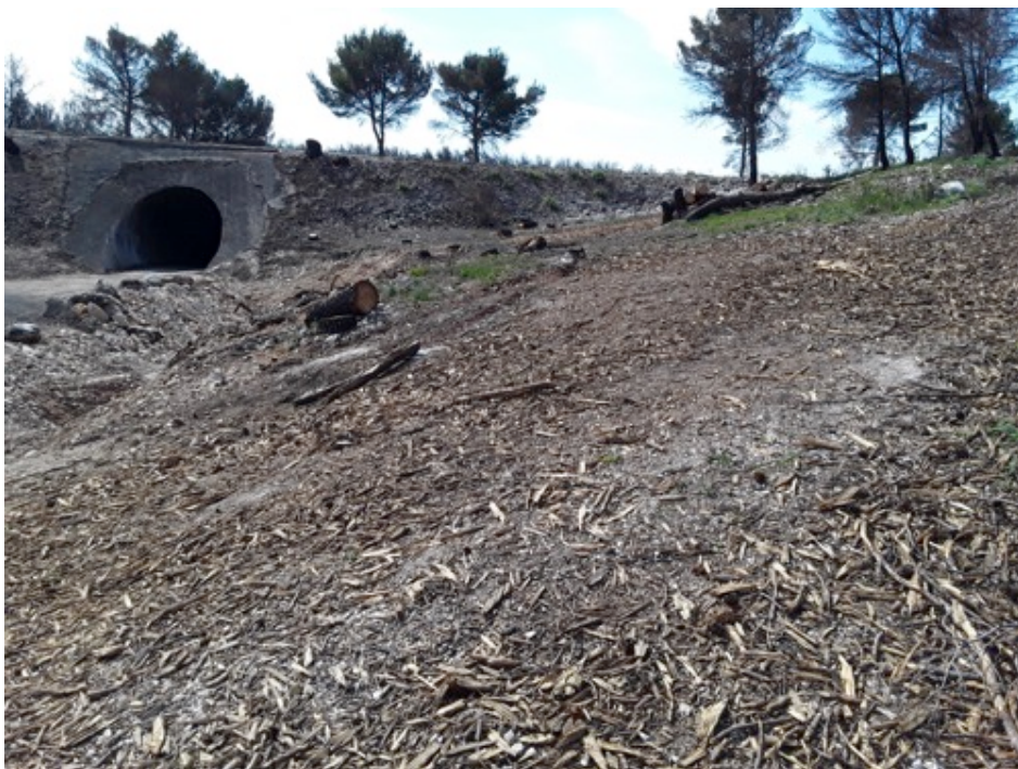
Zone de stockage N°1 (Voir carte en fin de rapport) en bord de piste au niveau de la zone située au nord de la route D9
