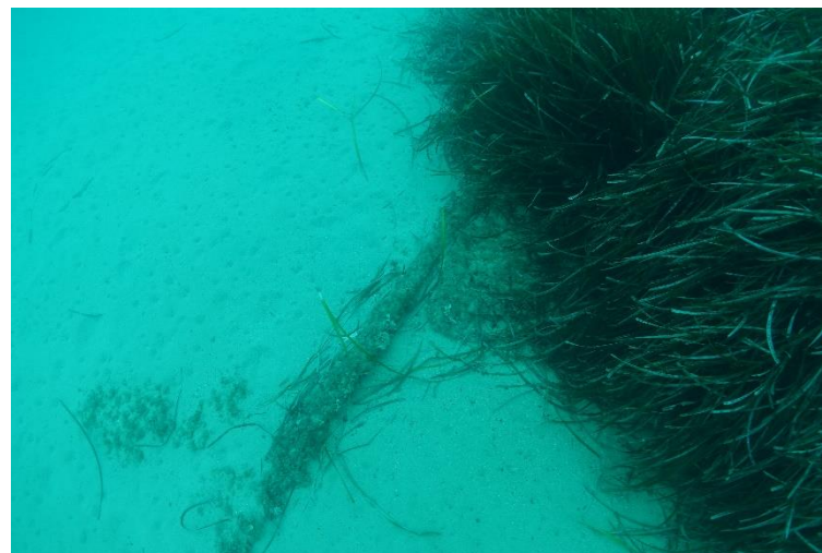
Figure 54 : Câble télécom en sortie d'herbier en limite supérieure (Marseille, 2020)
