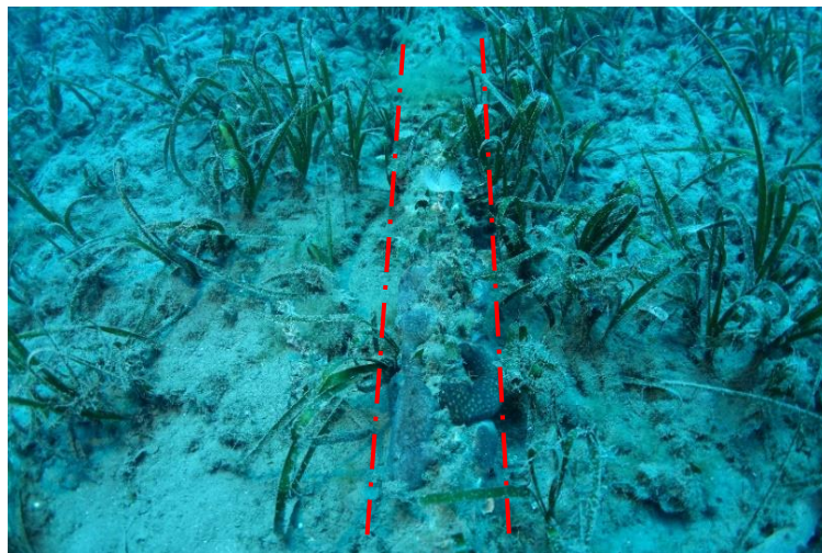
Figure 48 : Câble de transport d'énergie SACOI2 en limite inférieure de l'herbier entièrement colonisé (Bastia - plage de l'Arinella, 2020)
