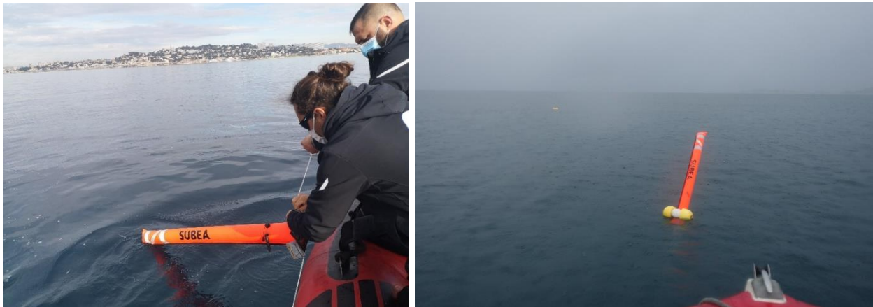
Figure 4 : Installation des balises le long du tracé du câble
