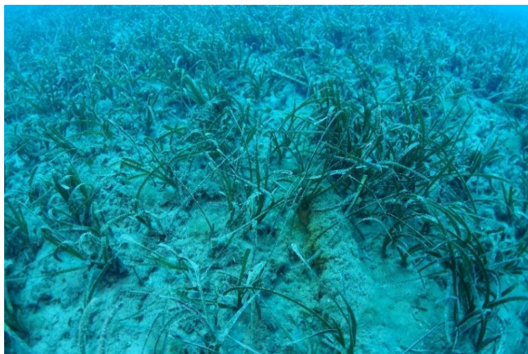
Figure 49 : Câble de transport d'énergie (SACOI2) en limite inférieure de l'herbier de posidonie et disparaissant dans la matre (Bastia - plage de l'Arinella, 2020)
