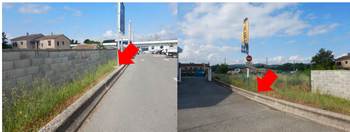
Figure 7 - Mur Jersey existant autour des parcelles à aménager
