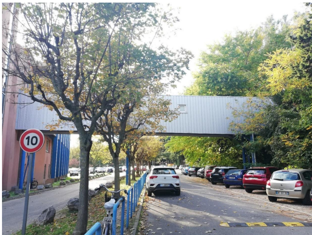
Photographie 3 : Passerelle et parking nord (Source : ENCIS Environnement)
