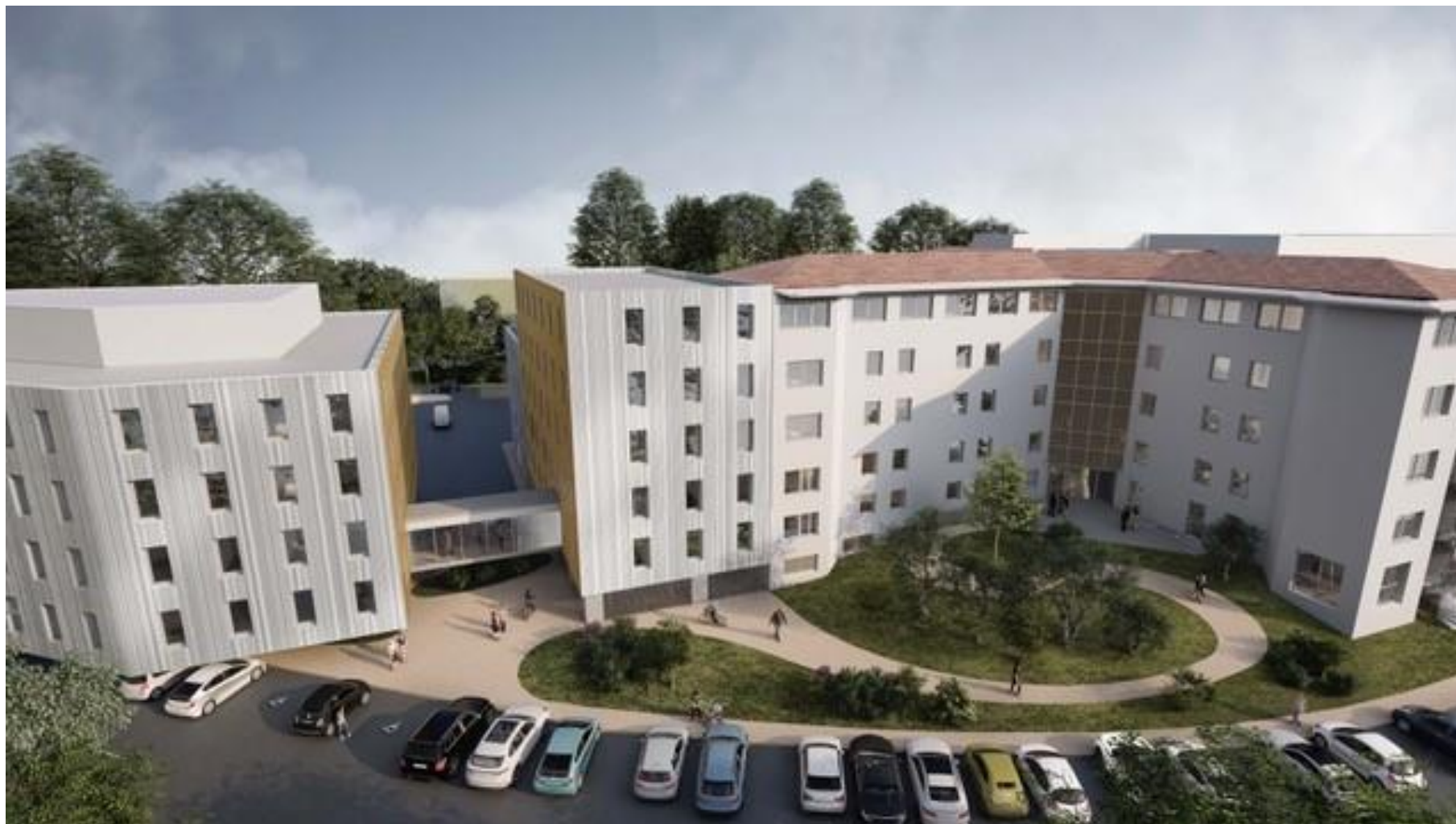
Figure 4 : Plan du projet d'extension de la clinique Rhône Durance en perspective (Source : Patriarche)
