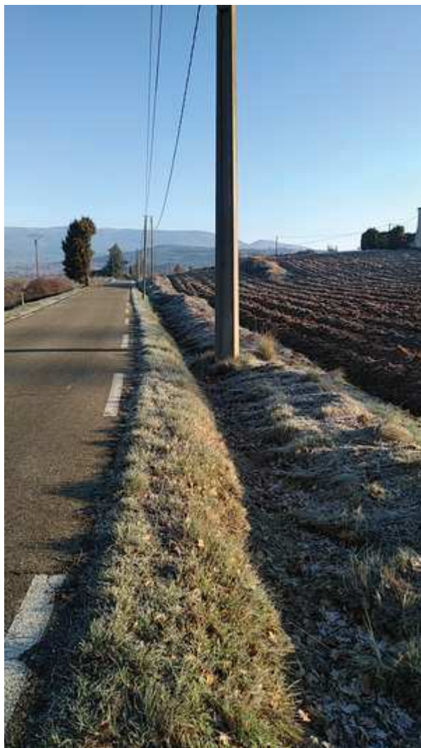
Photo N° 2 Vue du fossé Sud de la RD3
