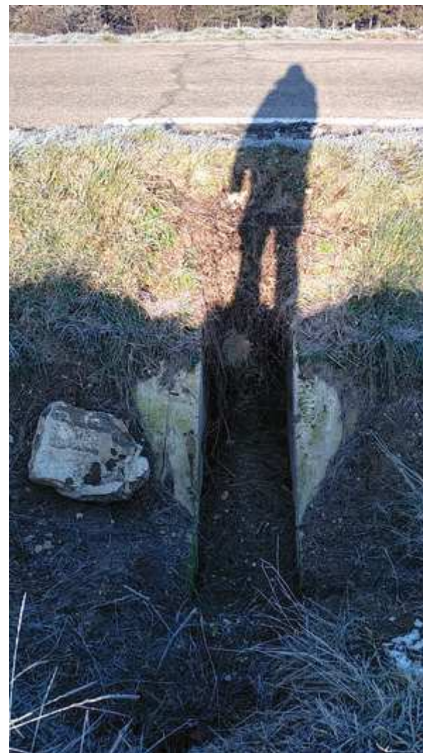
Photo N° 3 Vue du passage sous la RD3
