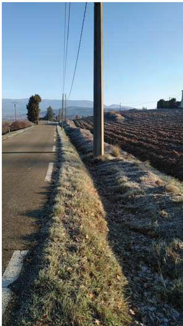
Photo N° 2 Vue du fossé Sud de la RD3
