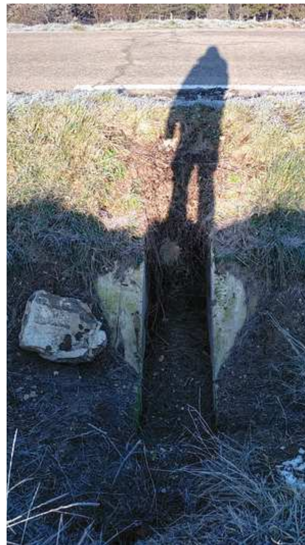
Photo N° 3 Vue du passage sous la RD3
