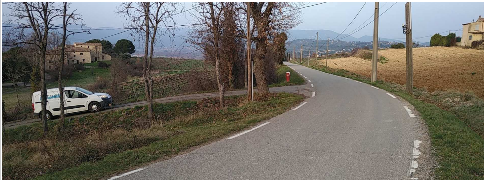
Photo N° 1 Vue de l'accès au site - RD3
