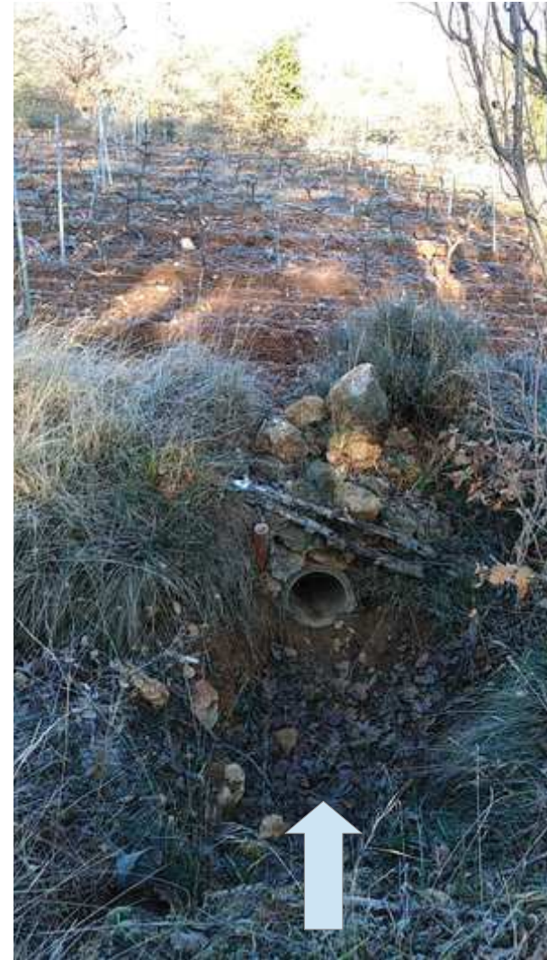
Photo N° 6 Vue du thalweg Nord – Aval du site
