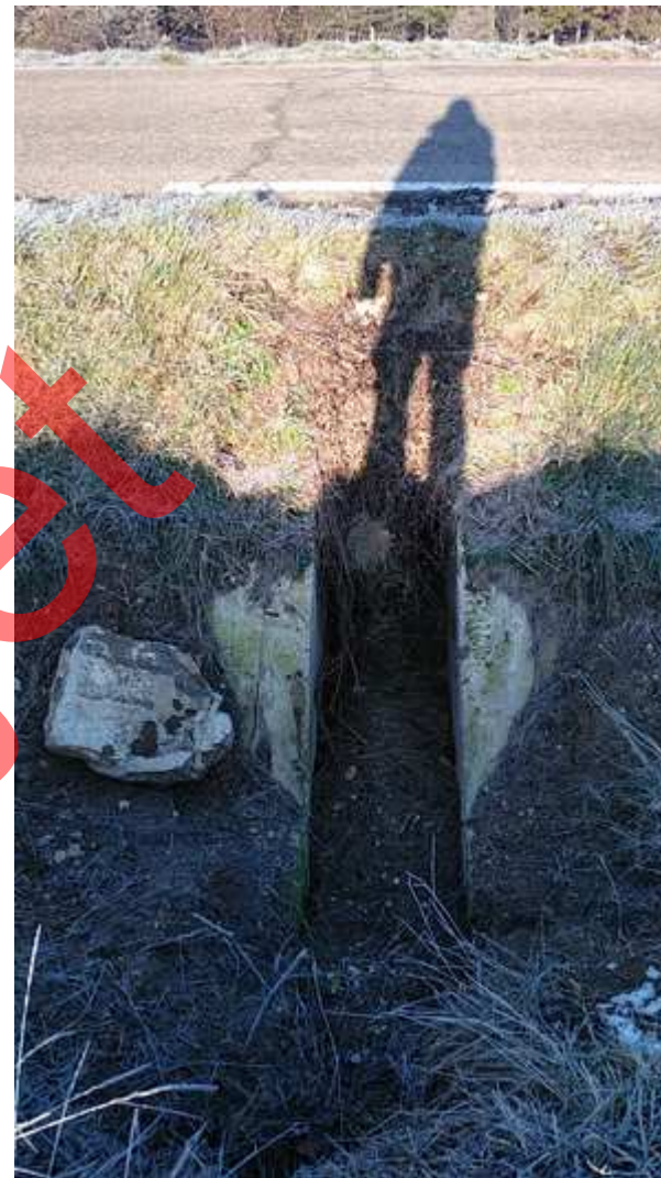
Photo N° 3 Vue du passage sous la RD3
