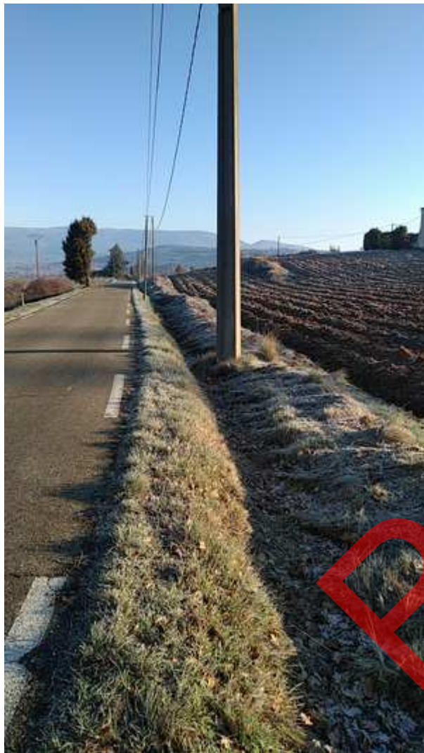
Photo N° 2 Vue du fossé Sud de la RD3
