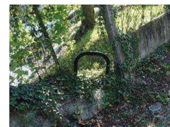
Photo 26. Passage à faune installé sur une clôture
