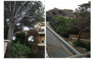
8 CYPRES EN MAUVAIS ÉTAT AFFECTÉ PAR LA DESTRUCTION DE LA PISCINE
