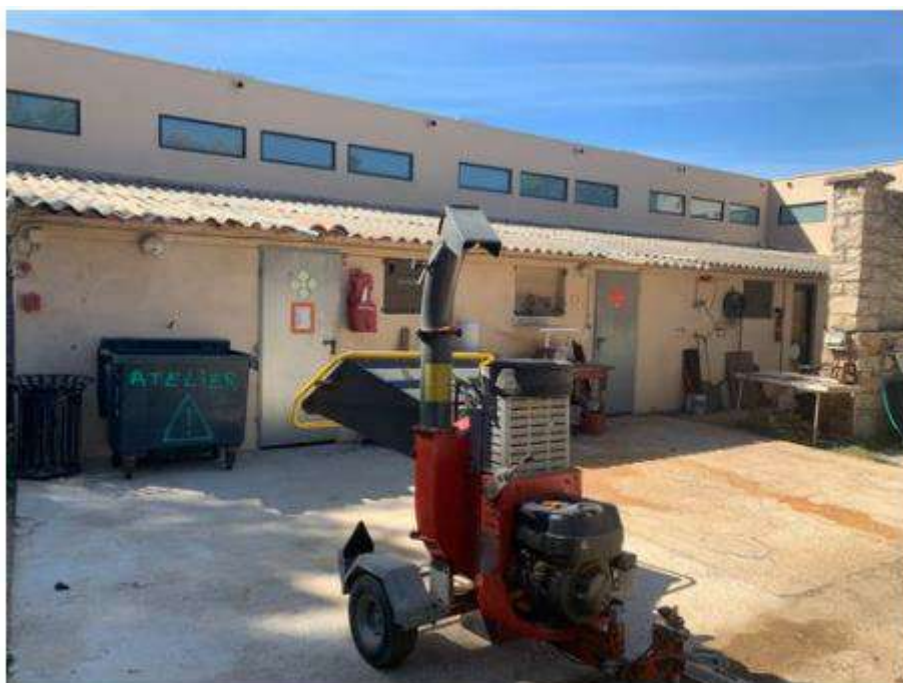
FIGURE 4 : ATELIER DE MAINTENANCE
