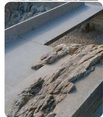
Roches et béton = l'utilisation du béton se veut plus parcimonieuse, dans le respect de la morphologie de la roche-mère, pour une meilleure perception, tout en continuant à permettre la protection du trait de côte contre l'érosion
