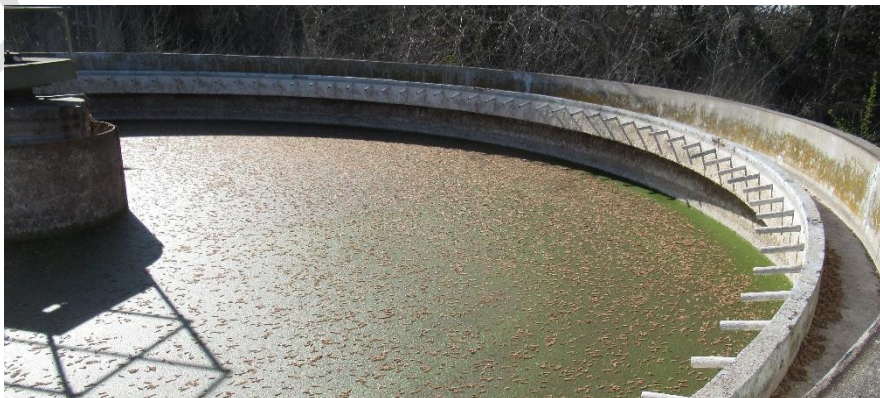
Figure 15. Bassin de l'ancienne station d'épuration. A noter le rebord empêchant la sortie de la faune une fois à l'intérieur. Photo sur site : Naturalia
