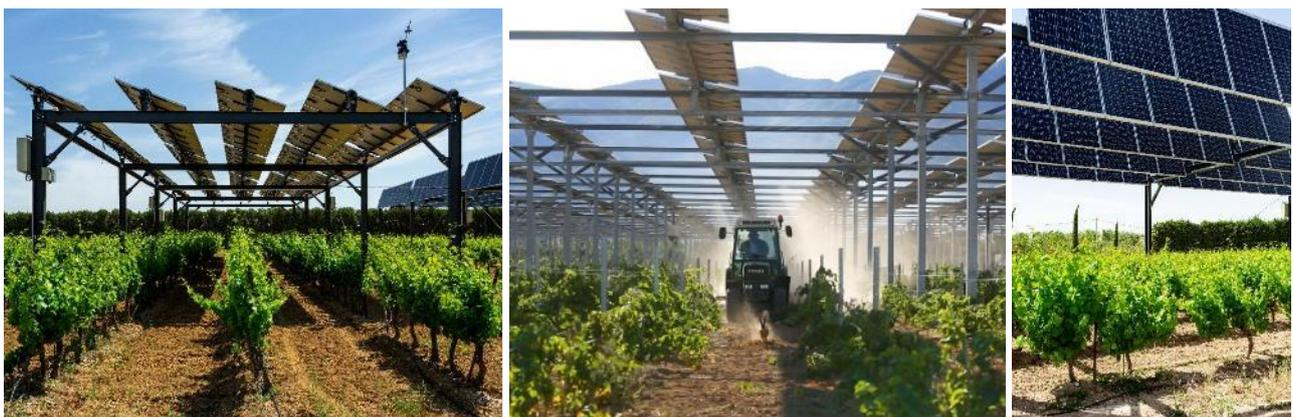
Figure 19. Illustrations d'une structure agrivoltaïque sur vignes (© Sun'Agri 2021)
