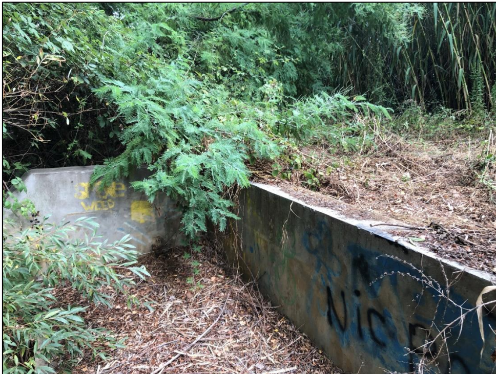
Figure 20 : Vue n°17 sur le fossé sur la portion Sud-Est de la zone de projet (Source : EKOS Ingénierie)
