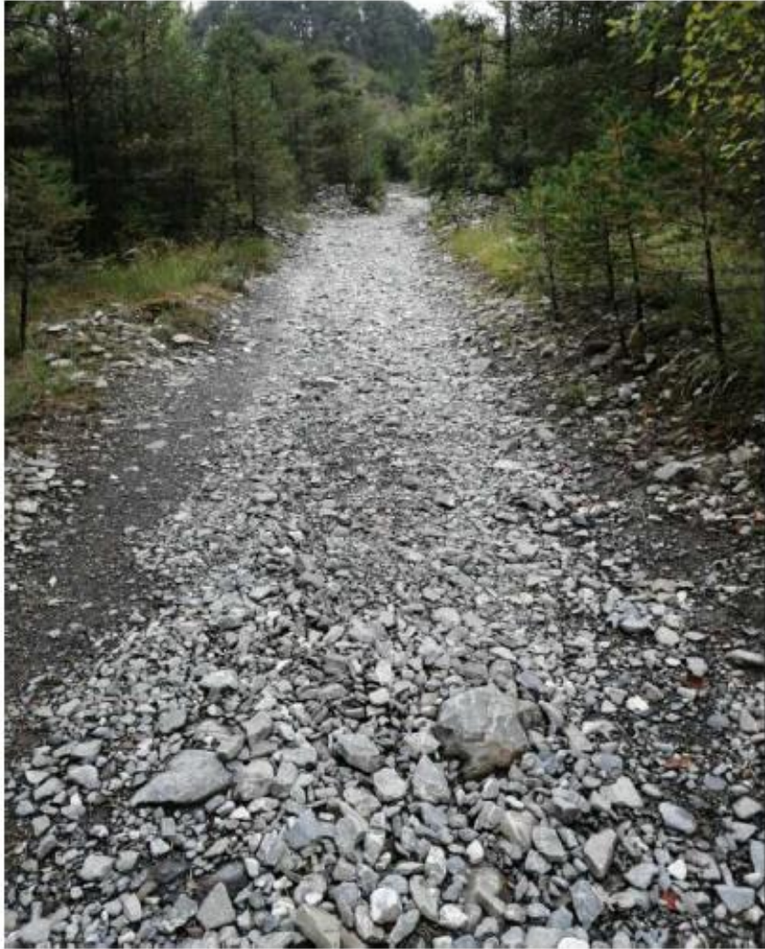
Passage sous la piste depuis le parking du gîte des Pinées
