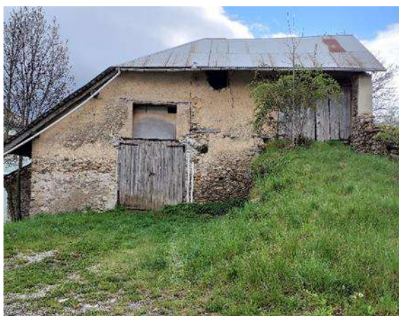
Bâti favorable au Grand et Petit rhinolophe (Gîte 2 : grange avec grenier et charpente)
