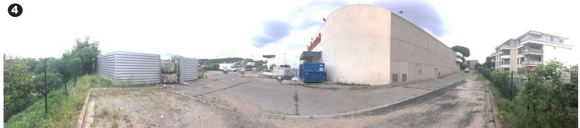
Vue sur l'aire de livraison - Chargement-Déchargement côté Sud de l'enseigne Conforama.
