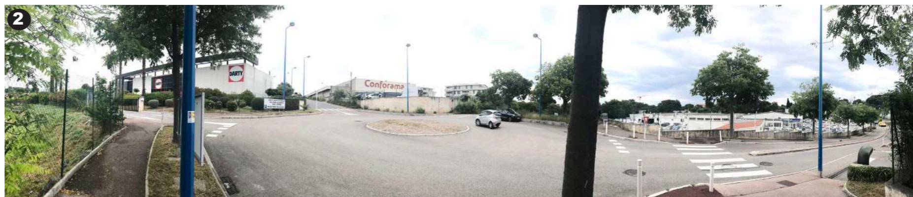
Vue depuis le giratoire Sud vers le site de l'actuel Conforama. A gauche l'entrée vers le site Darty. A droite le site Renault Antibes.
