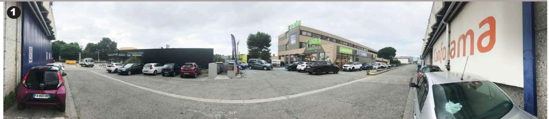
Vue depuis la voie de livraison longeant le Nord Est du site Conforama
