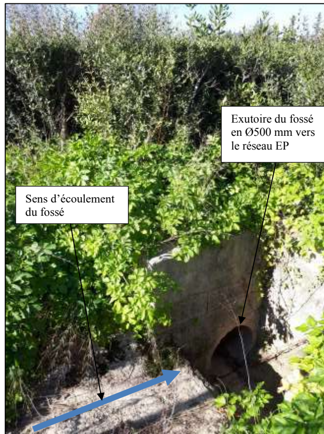
Photographie 2 : Exutoire du fossé traversant les terrains du projet
