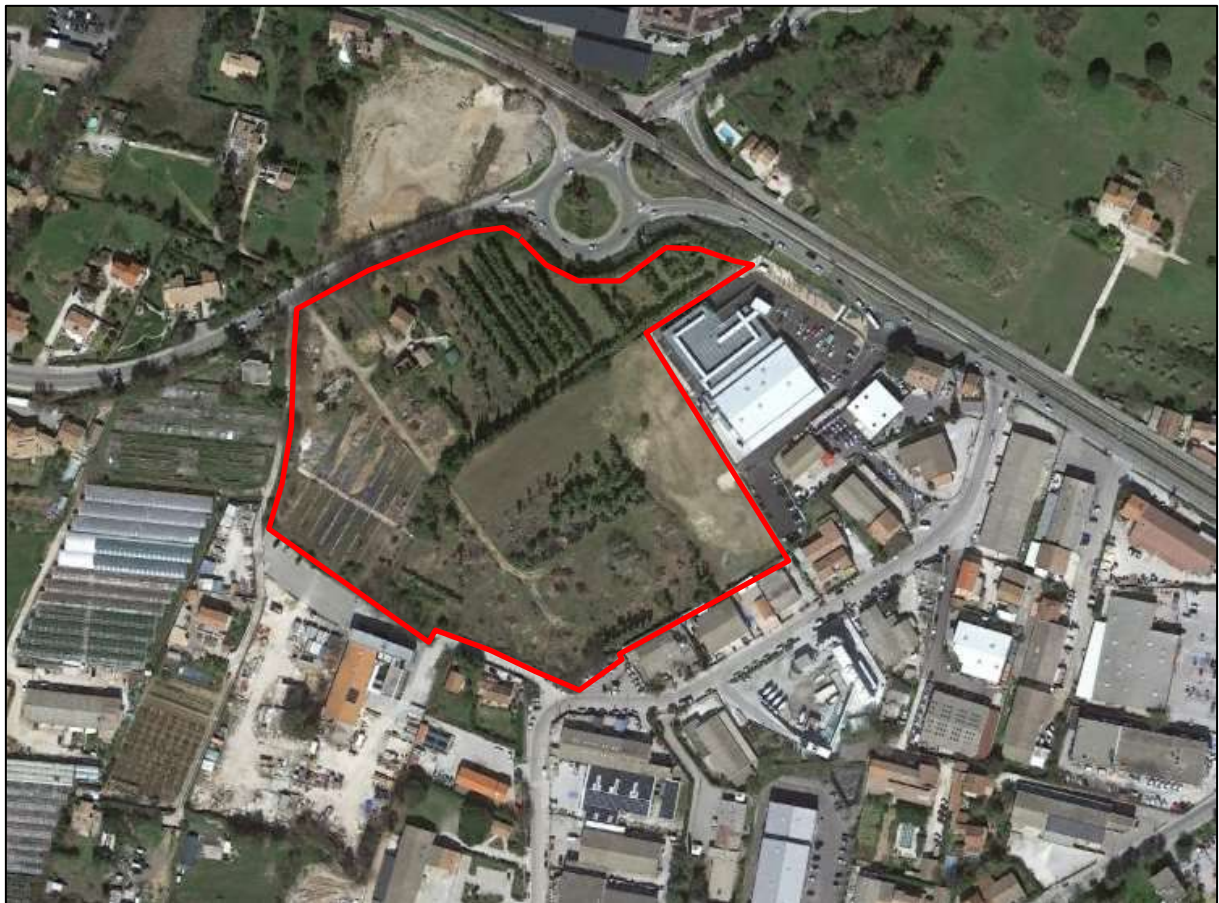
Vue satellite du terrain du projet
