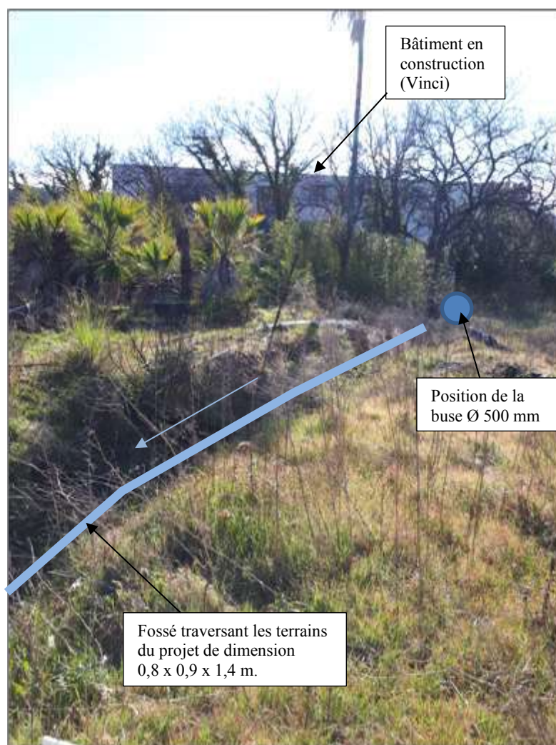
Photographie 1 : Vue du fossé traversant les terrains du projet
