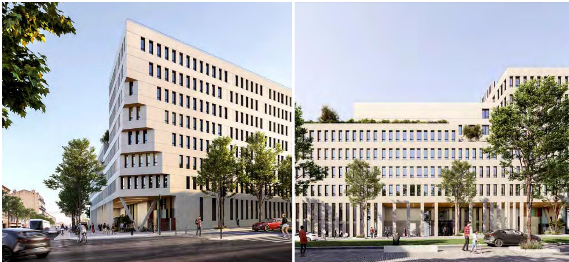
Figure 40 : 3B – BUREAUX : Angle Nord-Est et Façade Est vue depuis la rue de Lyon (Vincent Lavergne Architecture et Urbanisme / Kardham Cardete Huet Architecture)
