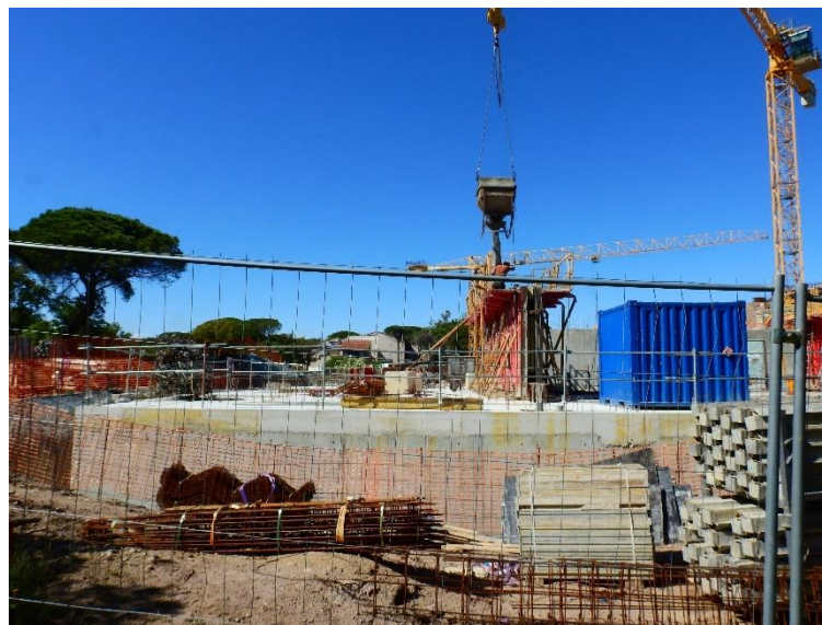
Chantier en cours partie centre est
