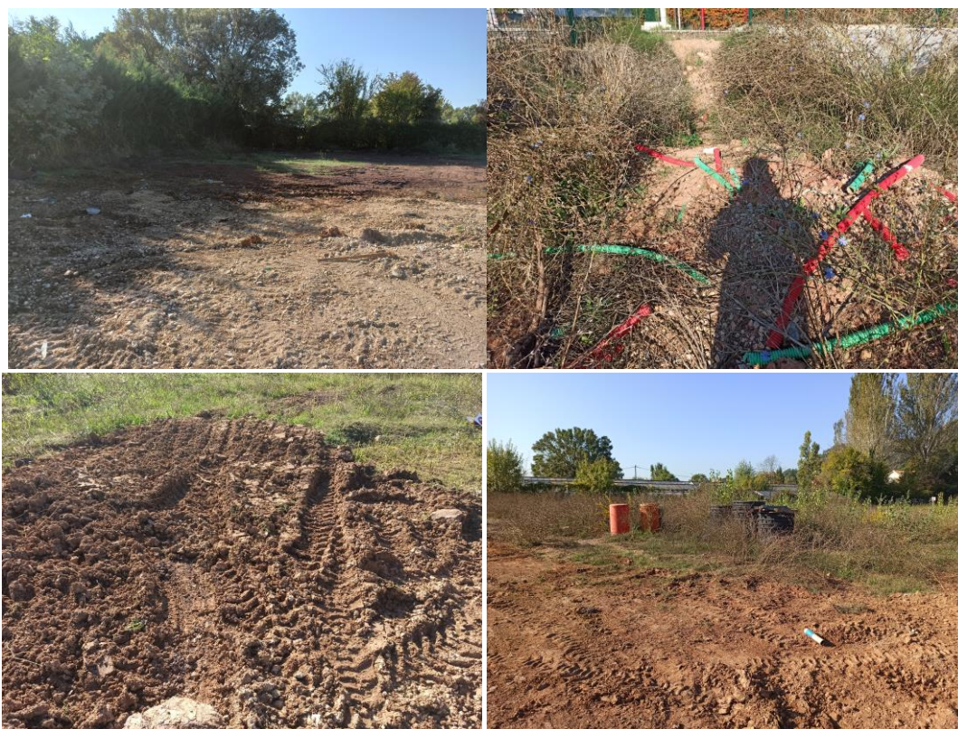
Photo 7 : Zones du secteur d'étude remaniées par les engins de chantier lors des formations (EVEN, Octobre 2021)
