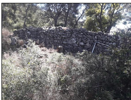
Ancien muret à l'ouest de la zone d'étude
