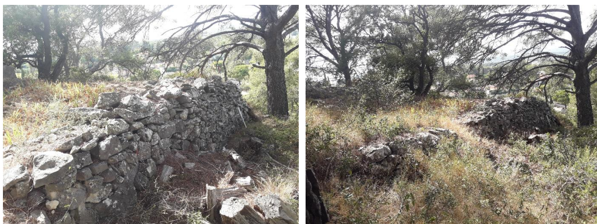
Exemple de muret peu favorable aux reptiles en train de se revégétaliser et exposé plein Nord
