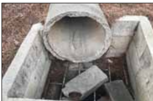
Vue de la canalisation se rejetant dans le réseau situé le long du Boulevard de l'Aspé
