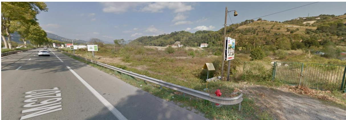
Figure 22 : Vue depuis la RM 6202 sur la parcelle en friche (en direction du Nord)
