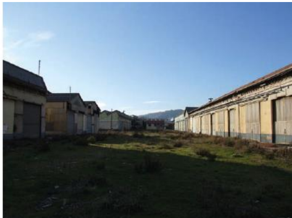
47. Le site en friche - photo 2019 - chargés d'étude
