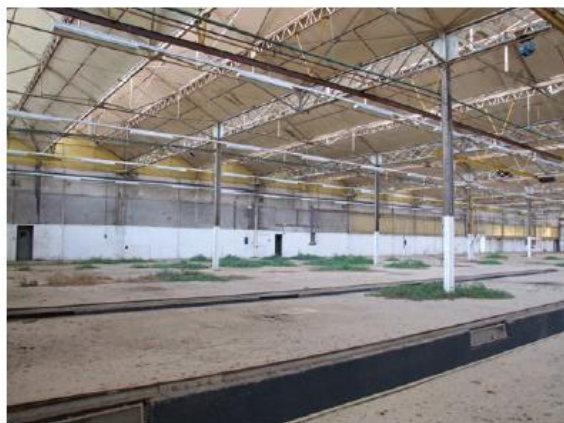
48. Bâtiment principal en friche - photo 2019 - chargé d'étude
