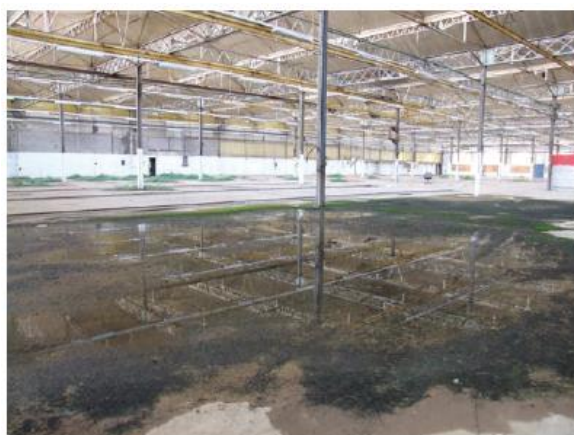
49. Bâtiment principal en friche - photo 2019 - chargé d'étude
