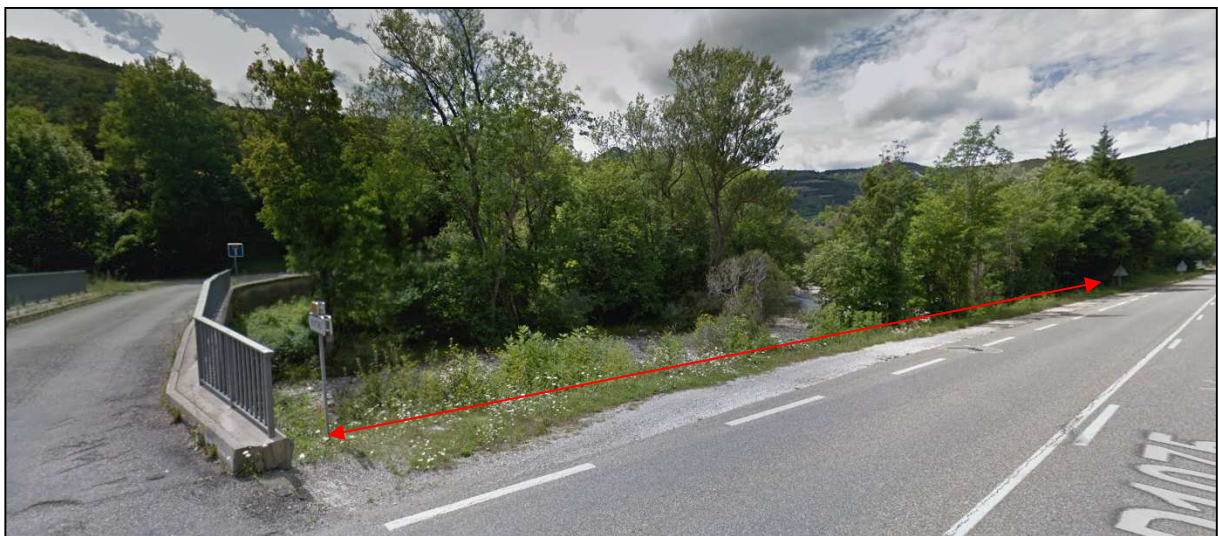
Figure 2: vue sur la berge à protéger – site 3 – Pont de Montama
