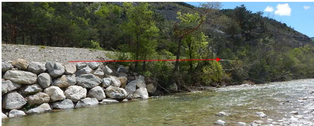
Figure 14: vue sur la berge à conforter – site 7
