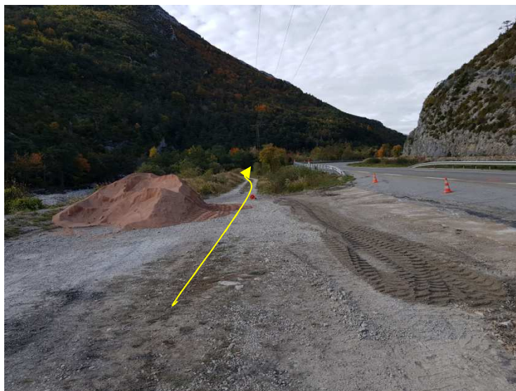
Figure 17: Zone d'installation de chantier – travaux site 8
