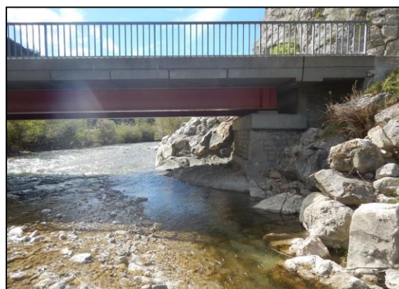
Figure 13 : Vue de l'amont - rive droite du pont des Oches (photo avril 2020)
