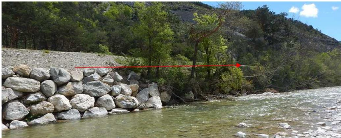
Figure 19 : Site 7 : vue sur la berge à conforter
