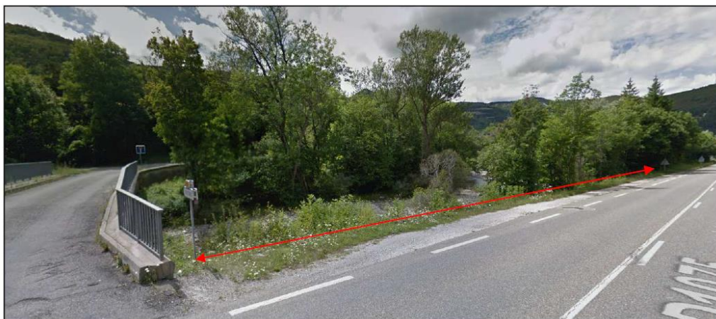
Figure 15 : Site 3 : Vue sur la berge à protéger –Pont de Montama
