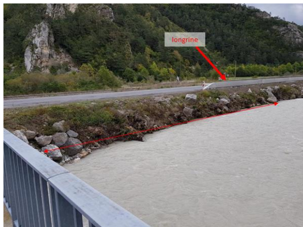
Figure 11: Vue sur le site n°1, rive gauche, et le linéaire à conforter (photo du 5 octobre 2020)
