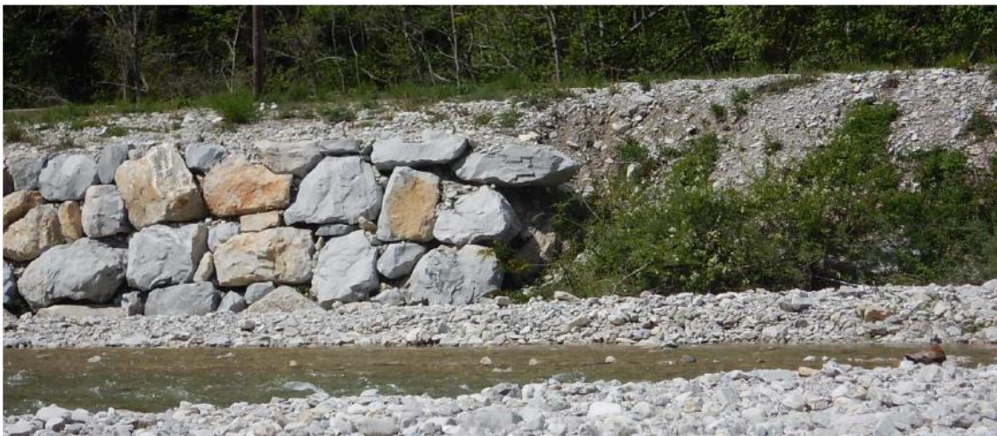
Figure 18 : Site 5bis : Extrémité de la protection existante
