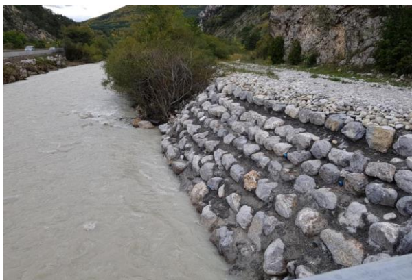
Figure 12 : Vue aval de la rive droite du pont des Oches (photo octobre 2020)
