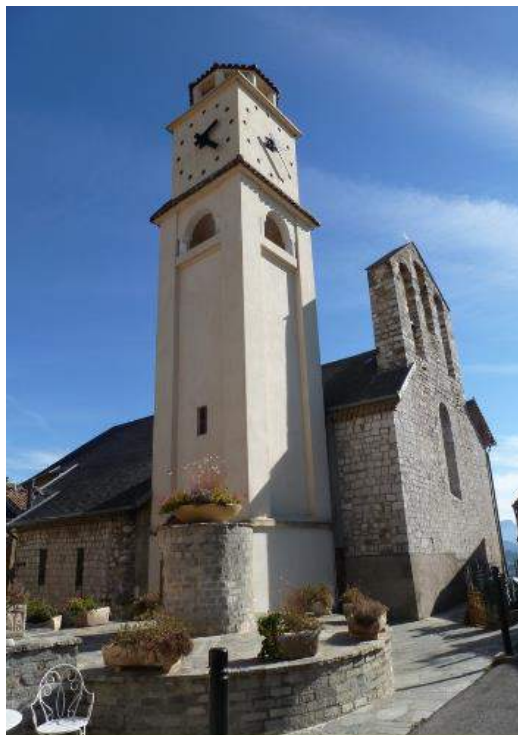
Photo 3 : Église de Ventavon
