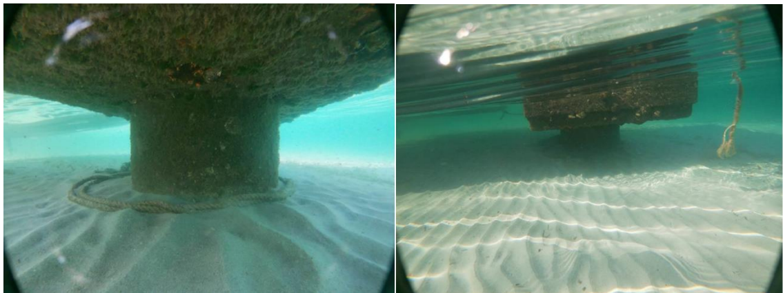
Figure 17 : Vue assise ponton existant
