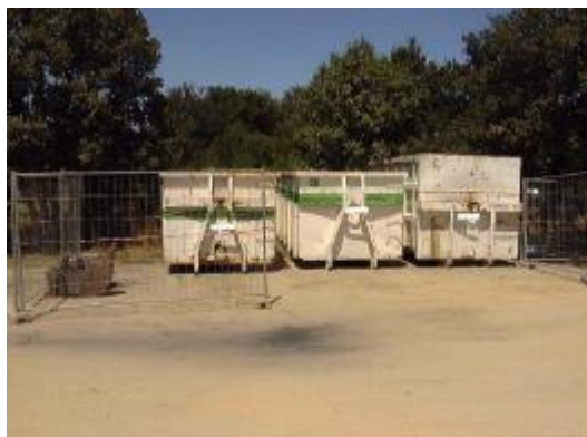
Figure 29 : Exemple de bennes destinées à accueillir les déchets de chantier
