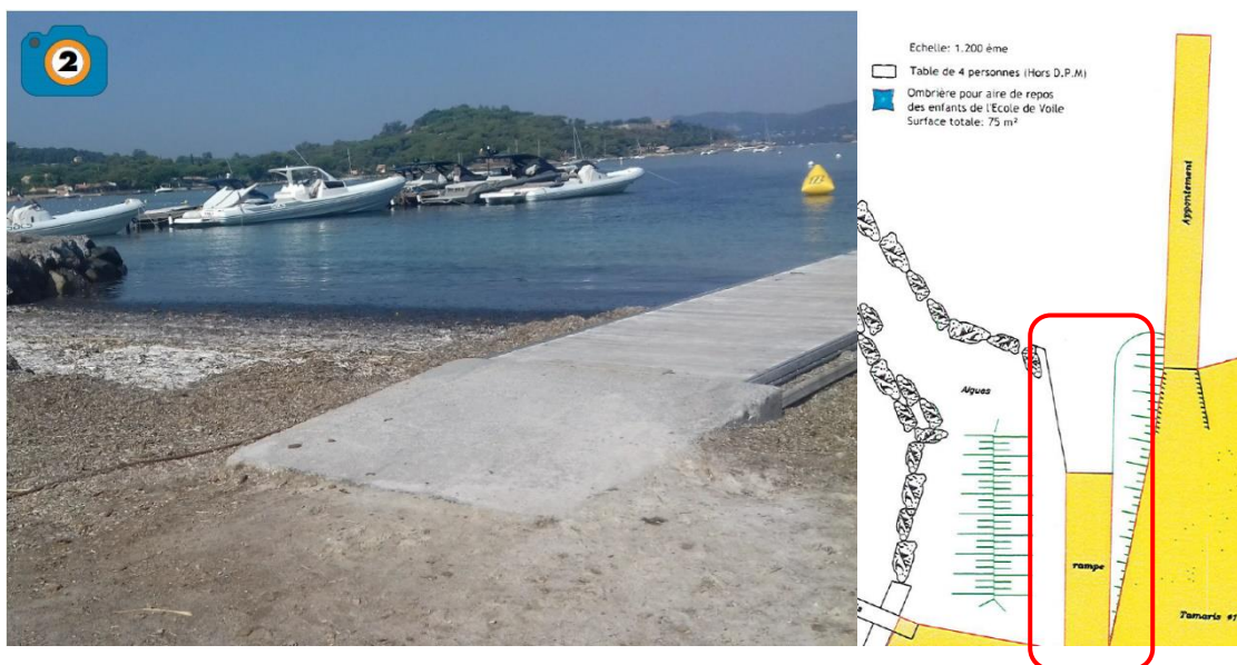
Figure 8 : Cale de mise à l'eau existante
