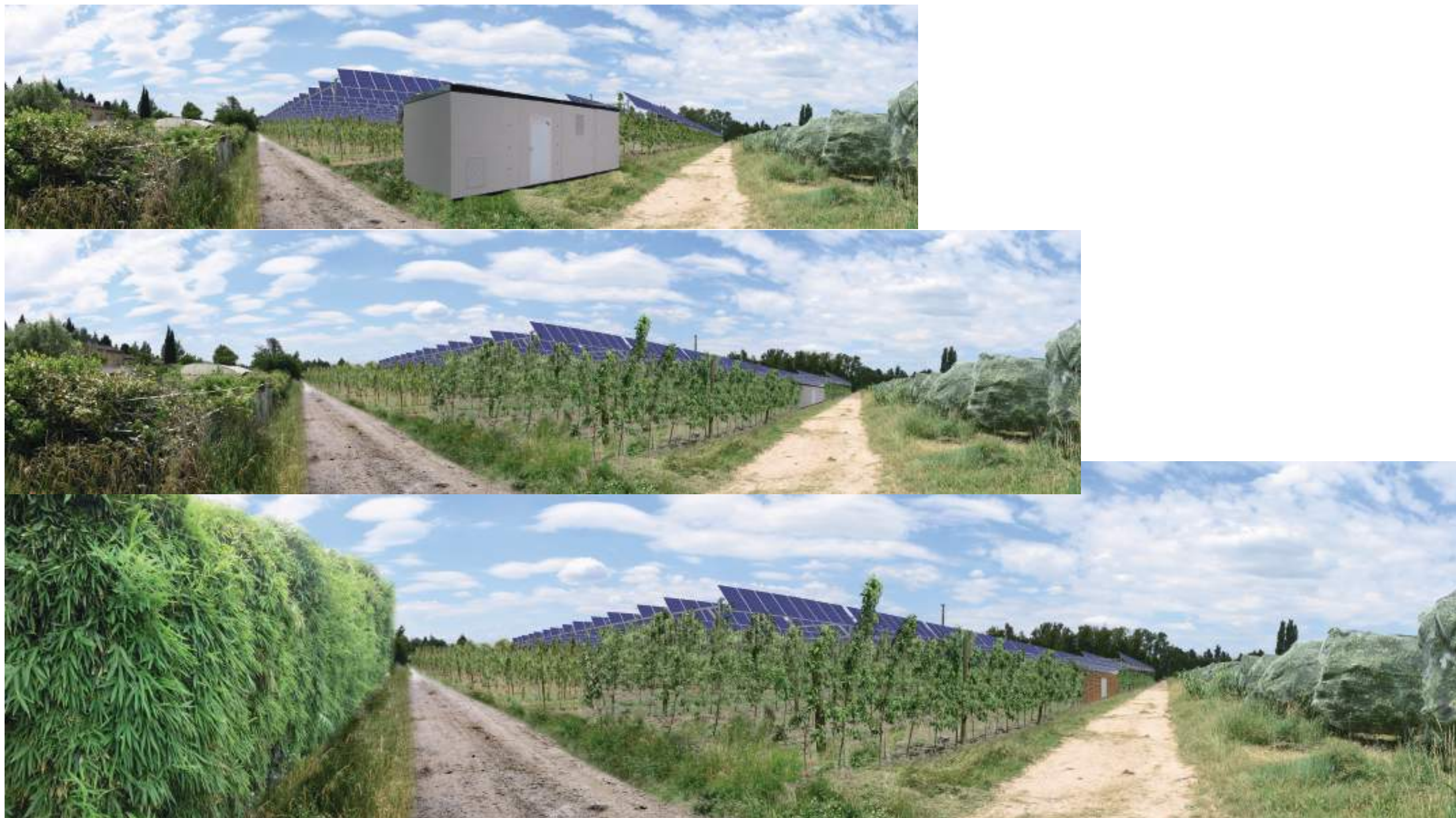
Photographie 26 : Mesure d'évitement (recul de l'implantation des persiennes et du poste) et mesure de réduction (plantation et bardage du poste de livraison).
