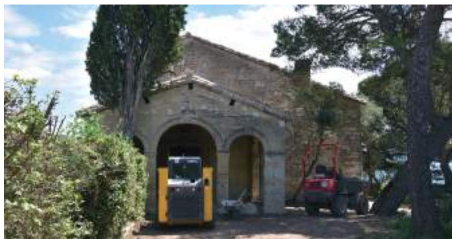
Photographie 11 : L'ermitage Saint-Jacques en cours de restauration.
