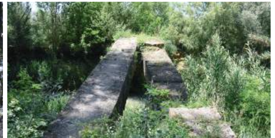
Photographie 9 : Pont aqueduc de la Canaù.
