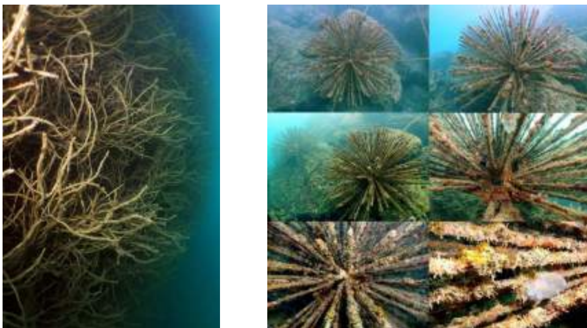
Figure 53: Exemple d'éco-conception d'ouvrages maritimes par ajout de solutions d'habillage (habitats artificiels, cavités, micro-habitats) (Source : Seaboost)
