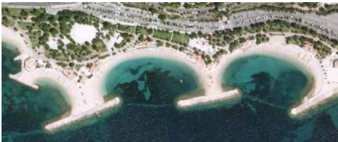
Butées de pied en enrochements à l'entrée des alvéoles du Mourillon à Toulon (photo Google)
