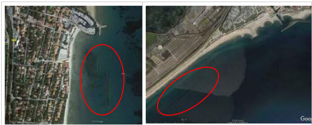
Brise-lames immergés en géotextiles – Plage de la Capte, Hyères (photo Google)
