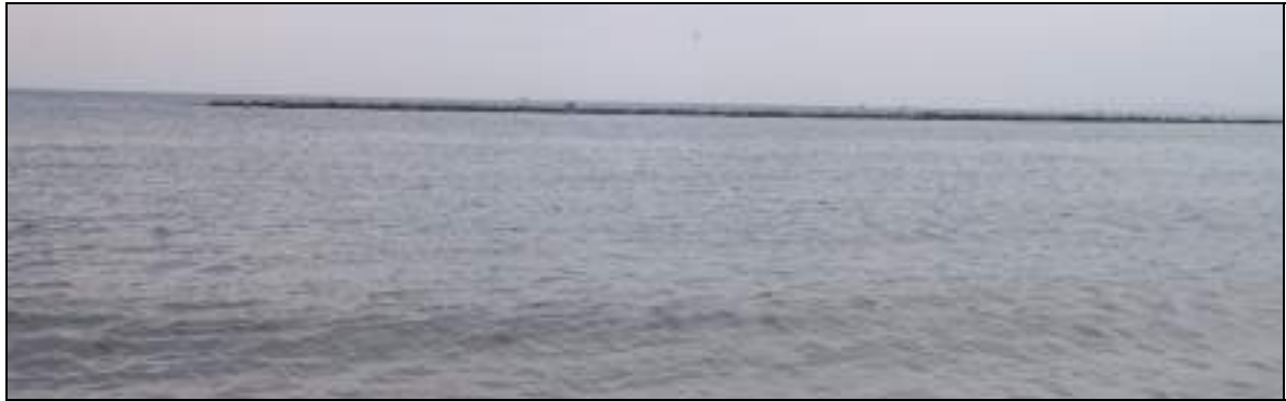
Brise-lames faiblement émergent des Battuts au Grau d'Agde en Méditerranée française (photo EGIS)
