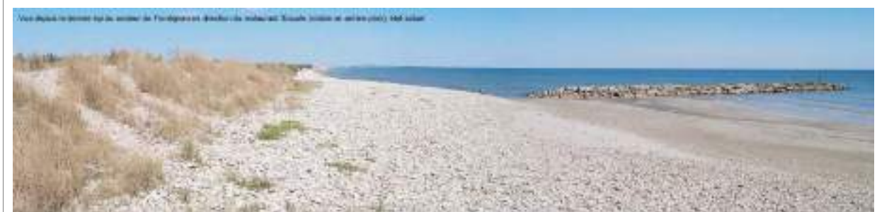
Accrétion/stabilisation en amont, érosion en aval transit d'un épi en enrochements (Frontignan)
