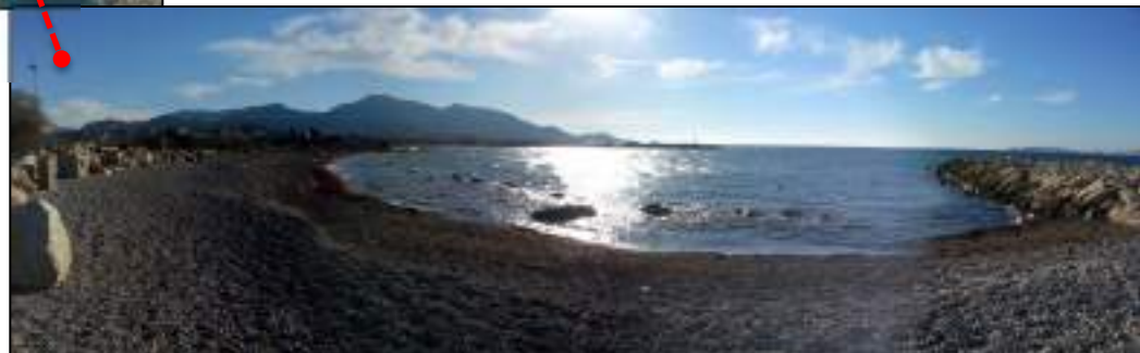
Ouvrage de protection du rejet d'eaux pluviales
