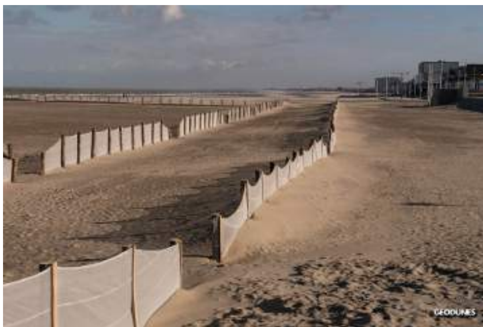
Accumulation de sable au niveau des filets brise vents installés à Dunkerque pour limiter l'envol du sable rechargé dernièrement (rechargement de la digue des Alliés ; source : Geodunes)
