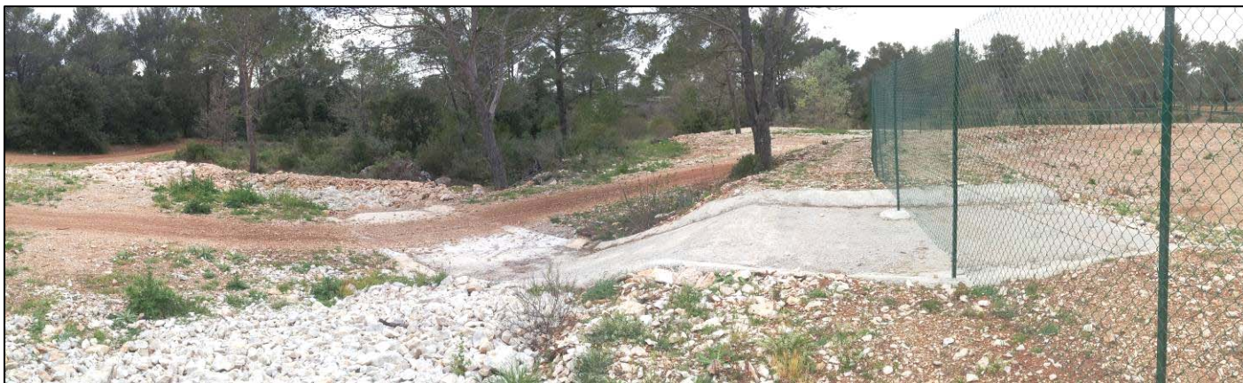
Photographie 3 : Vue vers le Nord de l'ouvrage de surverse du bassin de rétention RET3.
