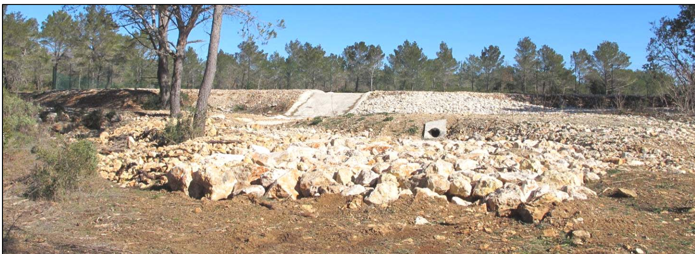
Photographie 4 : Vue vers le Nord-Est de la raquette en enrochements à la sortie du bassin de rétention RET3.
