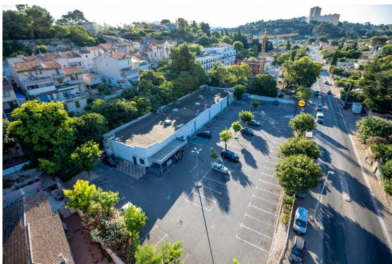
Vue aérienne du magasin existant
