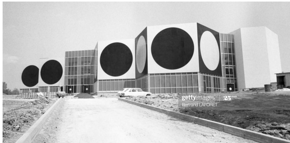
La fondation Vasarely en cours de travaux en 1975 - Gettyimages.fr
