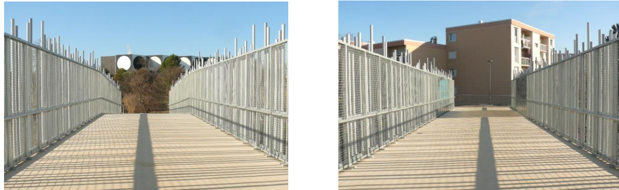
La passerelle de l'A51 et offrant des vues sur la fondation Vasarely, à gauche, et sur les Phares et Balises, à droite
