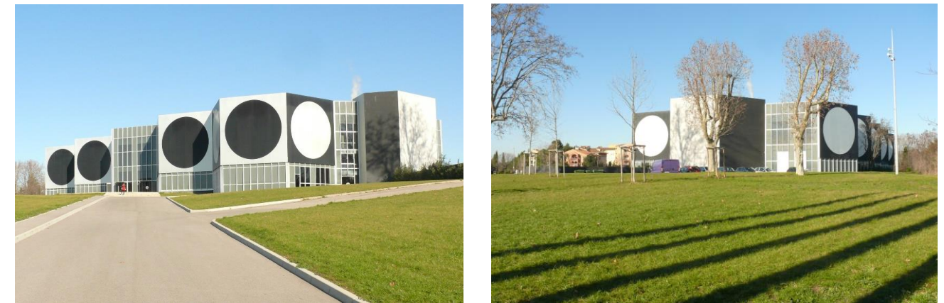
La fondation en janvier 2021
