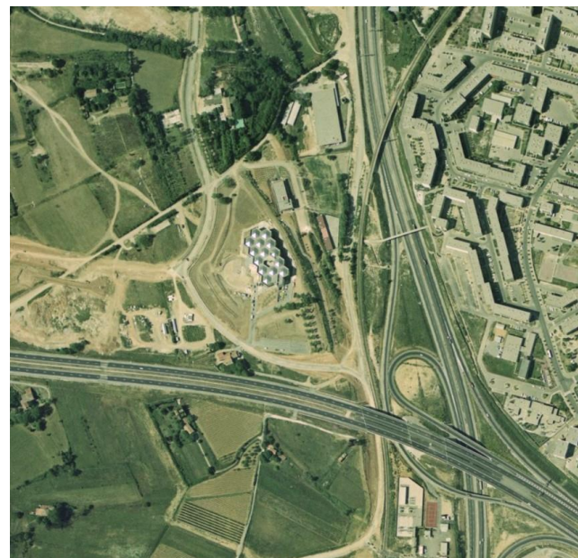
Fondation Vasarely en construction en 1975, le Signal V n'est pas encore implanté - remonterletemps.ign.fr
