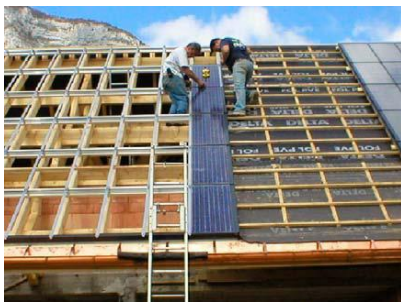
Toitures considérées comme intégrées au bâtiment
