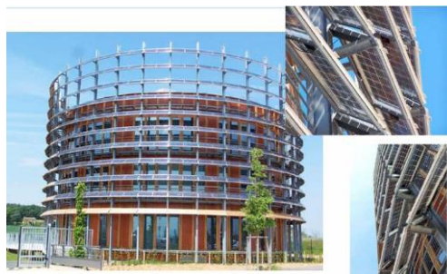
Brise soleil considéré comme intégré au bâtiment
