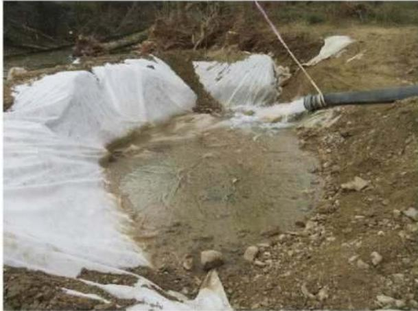
Exemple de bassin de décantation en parallèle du cours d'eau, pour filtrer les eaux de la pompe d'exhaure.
