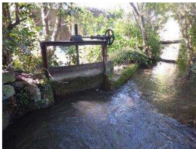
Assurer une répartition des débits équitable entre le tronçon court-circuité et le tronçon 1
