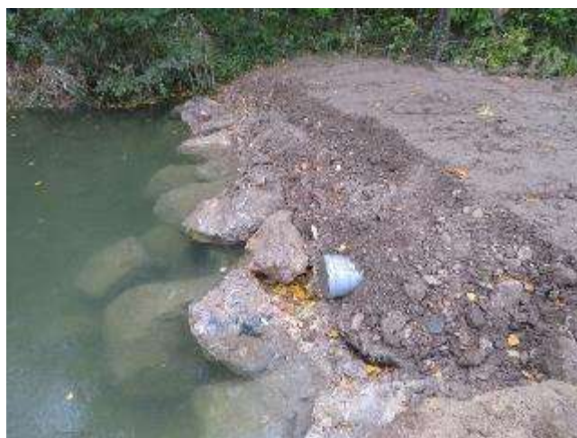
Exemple de batardeau réalisé avec un merlon constitué des matériaux du lit du ruisseau.
