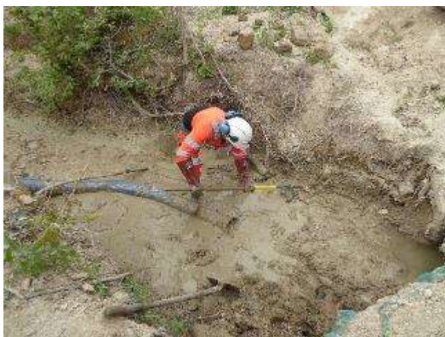
Désenvaser le tronçon à l'aide d'une hydrocreuse.
