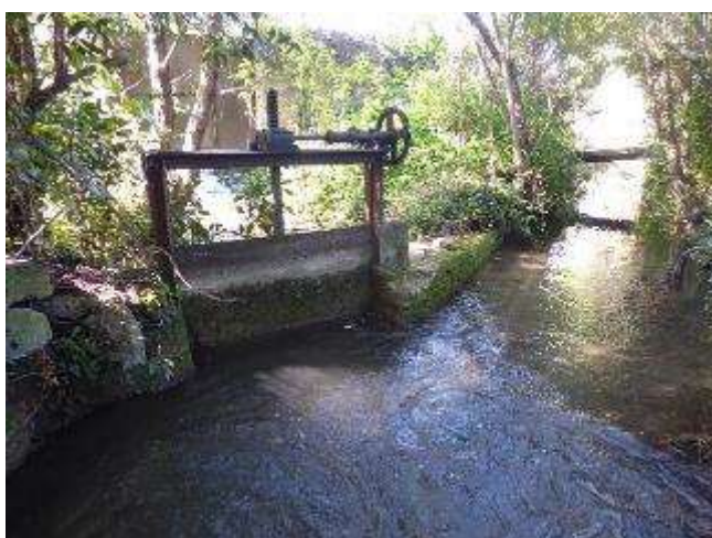
Les débits entre le canal secondaire et le tronçon 1 sont régulés par un vannage.
