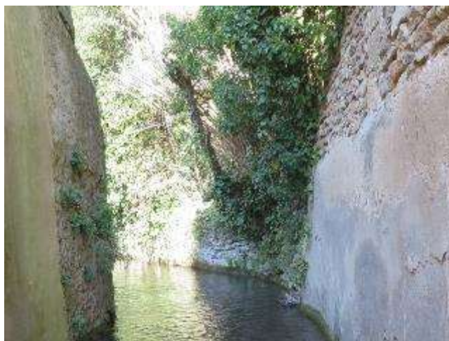
Végétation médio-européenne dominée par la Cymbalaire des murs et la Doradille rue-des-murailles investie les vieux murs du tronçon n°3 du canal principal
