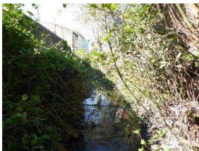
A l'aval du vannage, les débits dans le ruisseau sont faibles et favorisent l'envasement.
