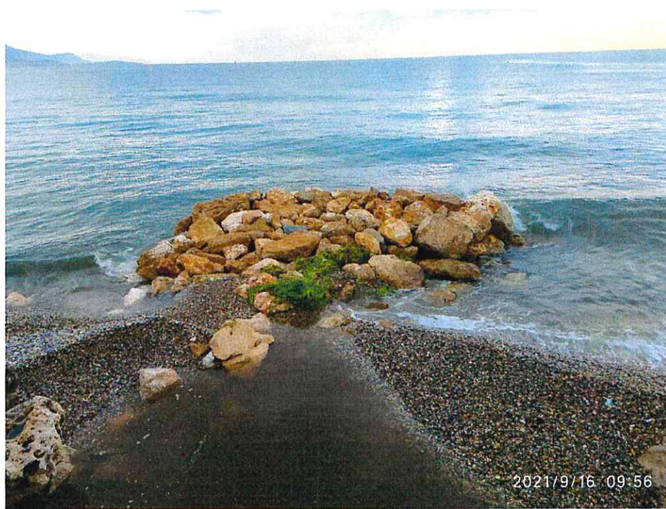
Figure 3 : Ouvrage en enrochement devant le passage Garbéro ICTP 2021
