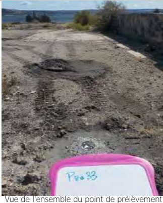
Vue de l'ensemble du point de prélèvement
