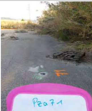
Vue de l'ensemble du point de prélèvement
