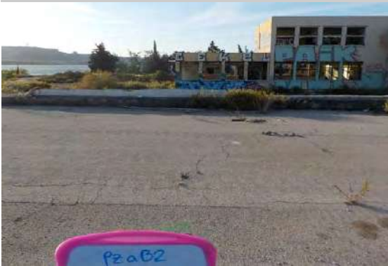
Vue de l'ensemble du point de prélèvement
