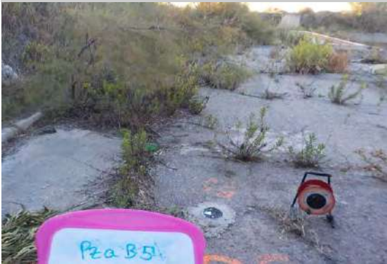
Vue de l'ensemble du point de prélèvement
