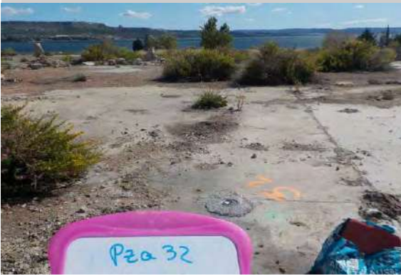
Vue de l'ensemble du point de prélèvement
