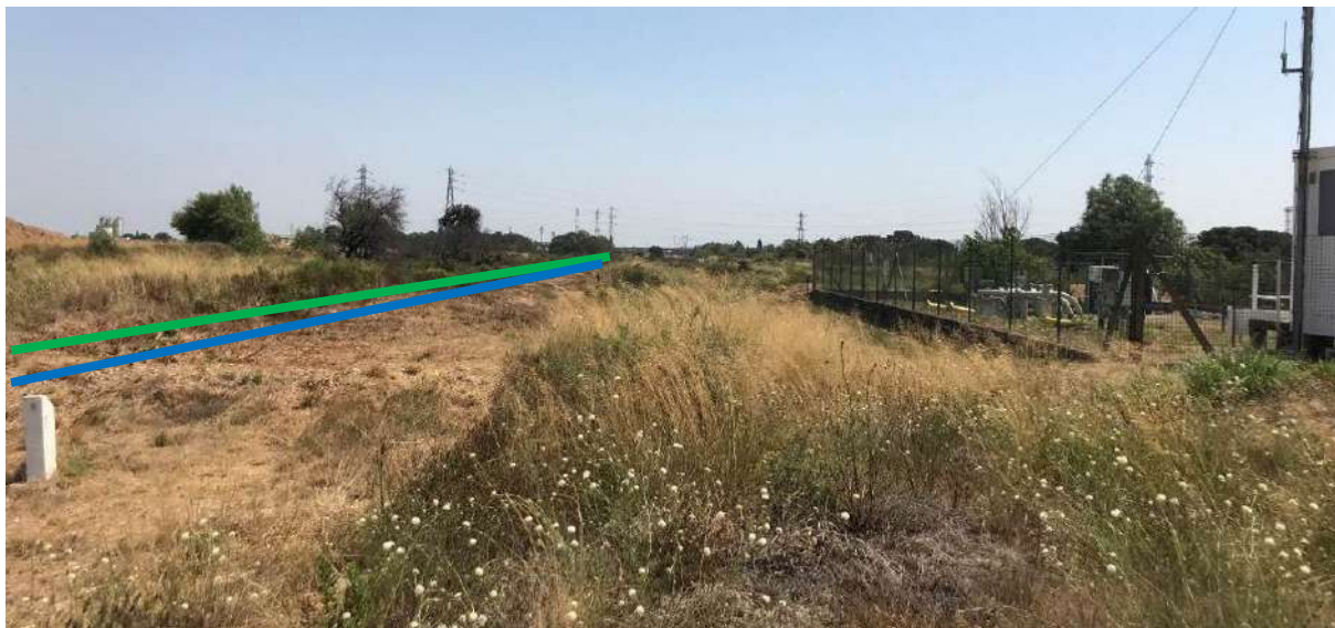
Photo 28 : Pose dans la nappe de canalisations
