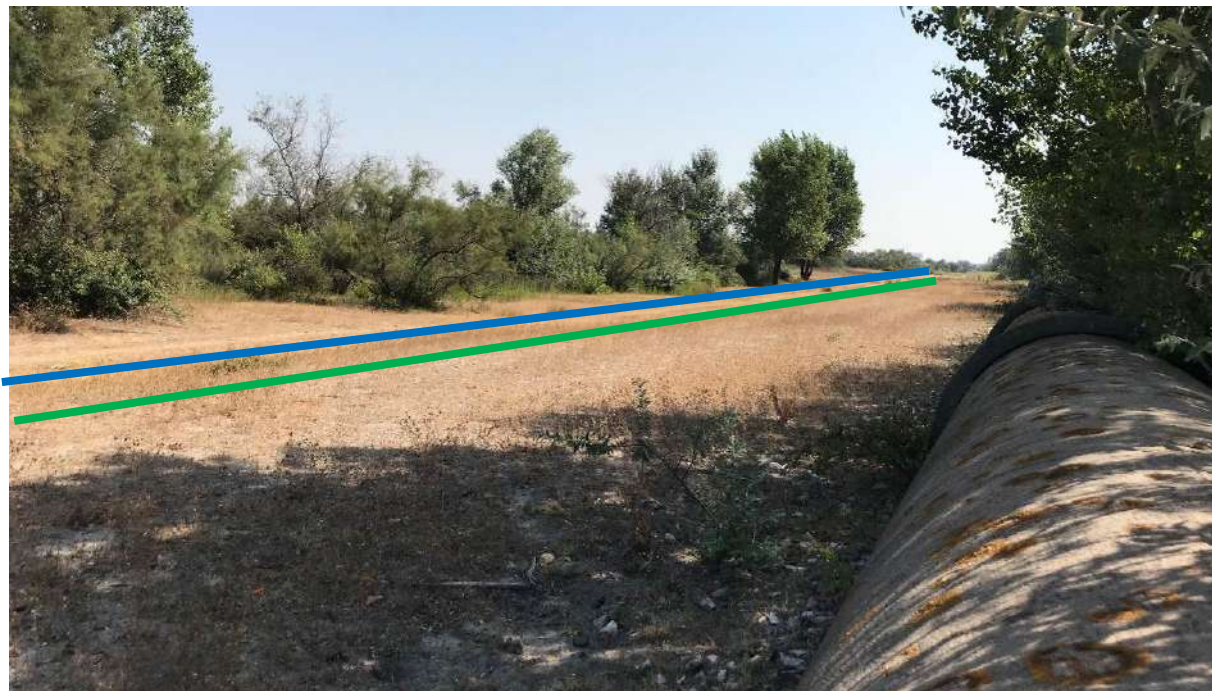
Photo 12 : Pose en tranchée dans la nappe du GPMM
