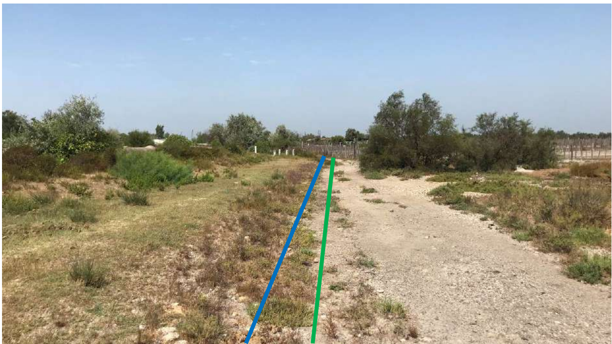
Photo 17 : Pose en tranchée dans le chemin
