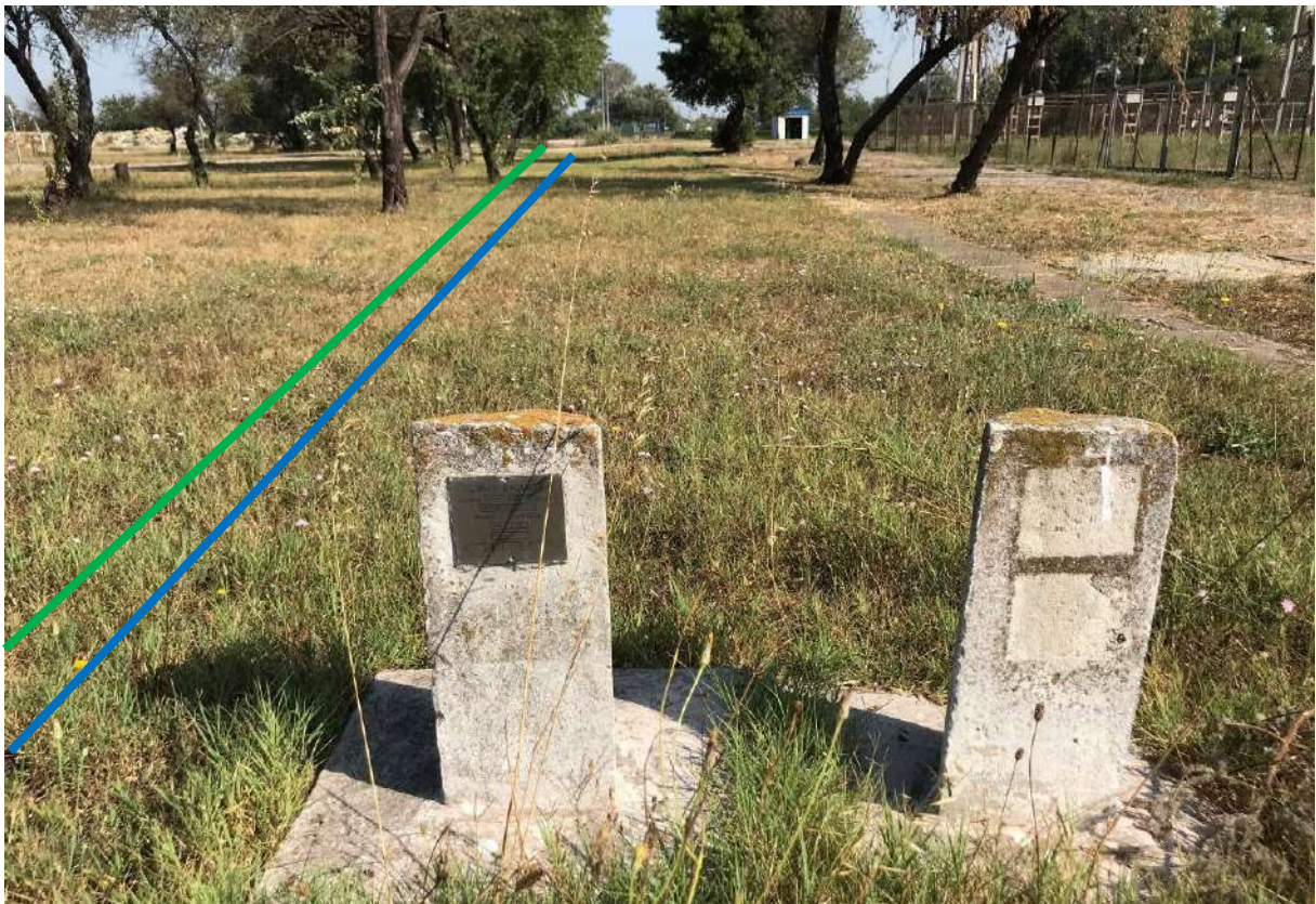
Photo 7 : Pose en tranchée en parallèle des réseaux existants (O2 et H2)
