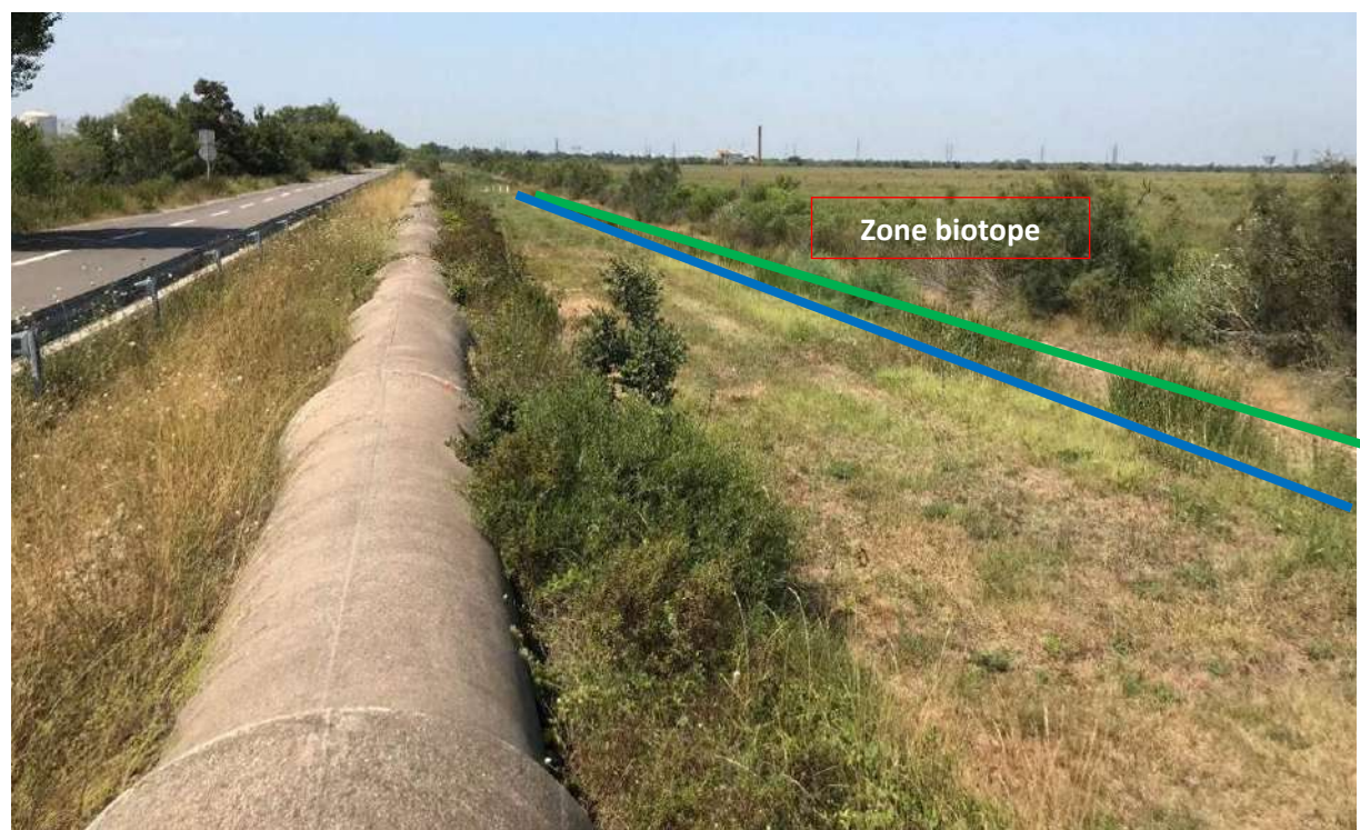
Photo 21 : Pose en tranchée en limite de la zone biotope
