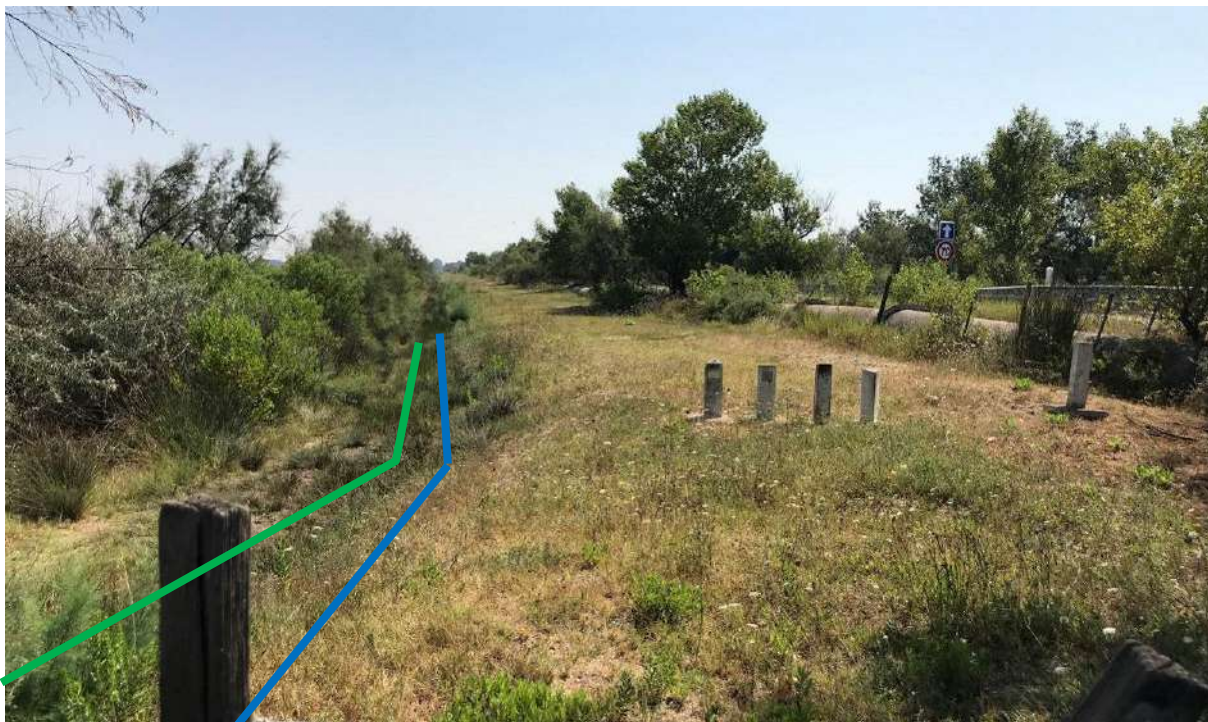
Photo 19 : Pose en tranchée en limite de la zone biotope
