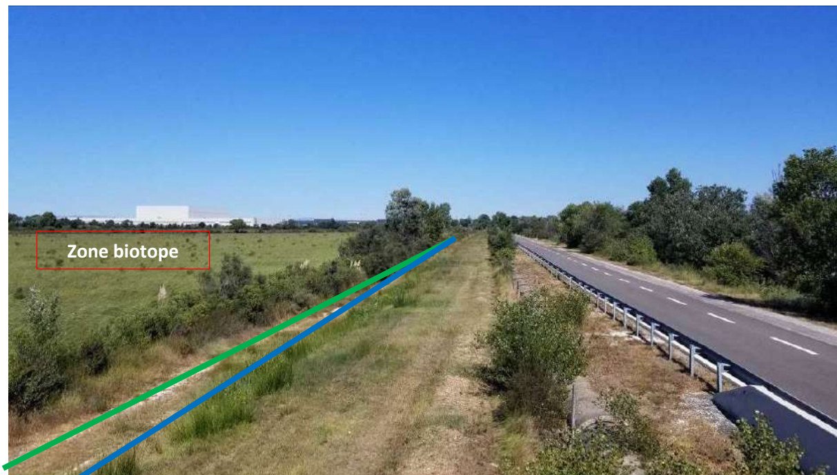
Photo 20 : Pose en tranchée en limite de la zone biotope
