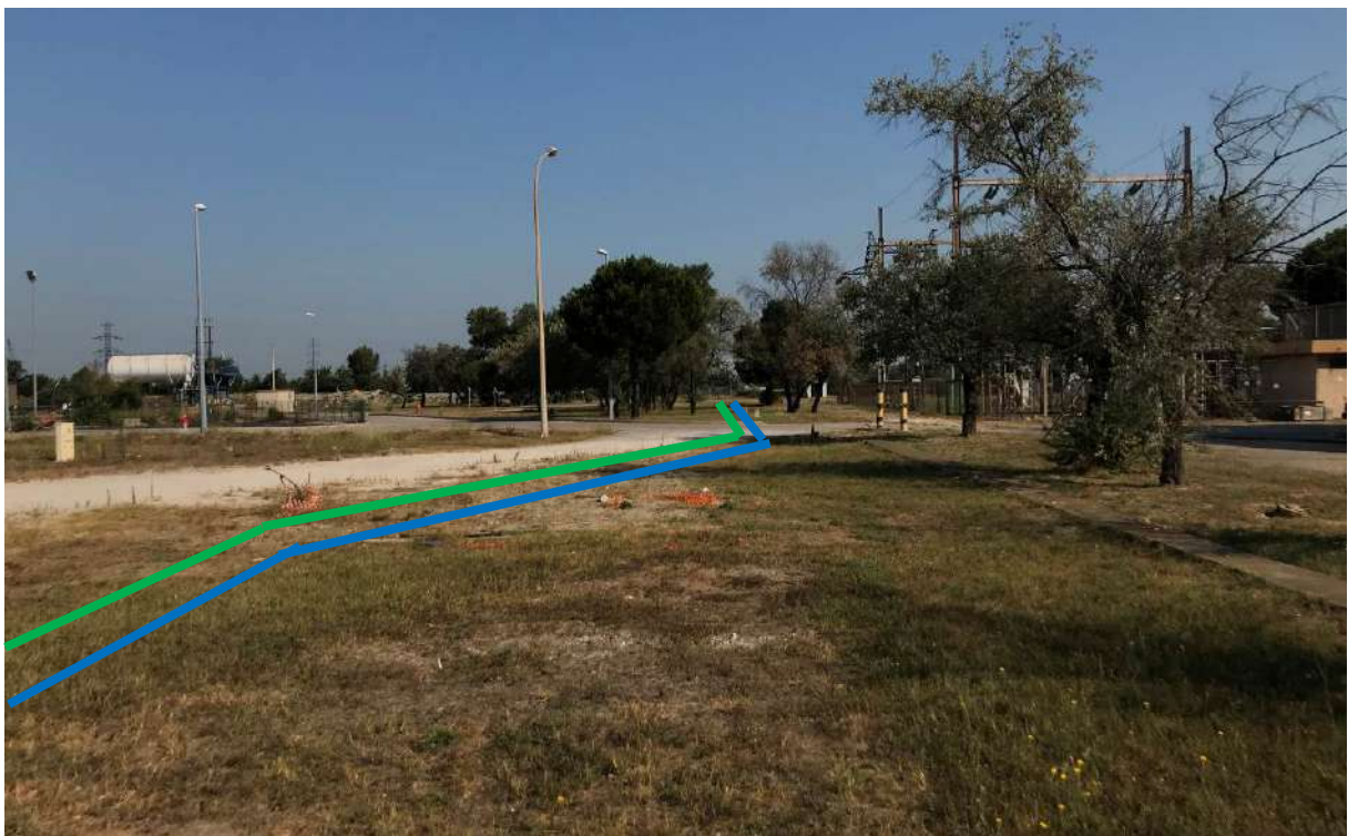
Photo 5 : Pose en tranchée en parallèle des réseaux existants (O2 et H2)
