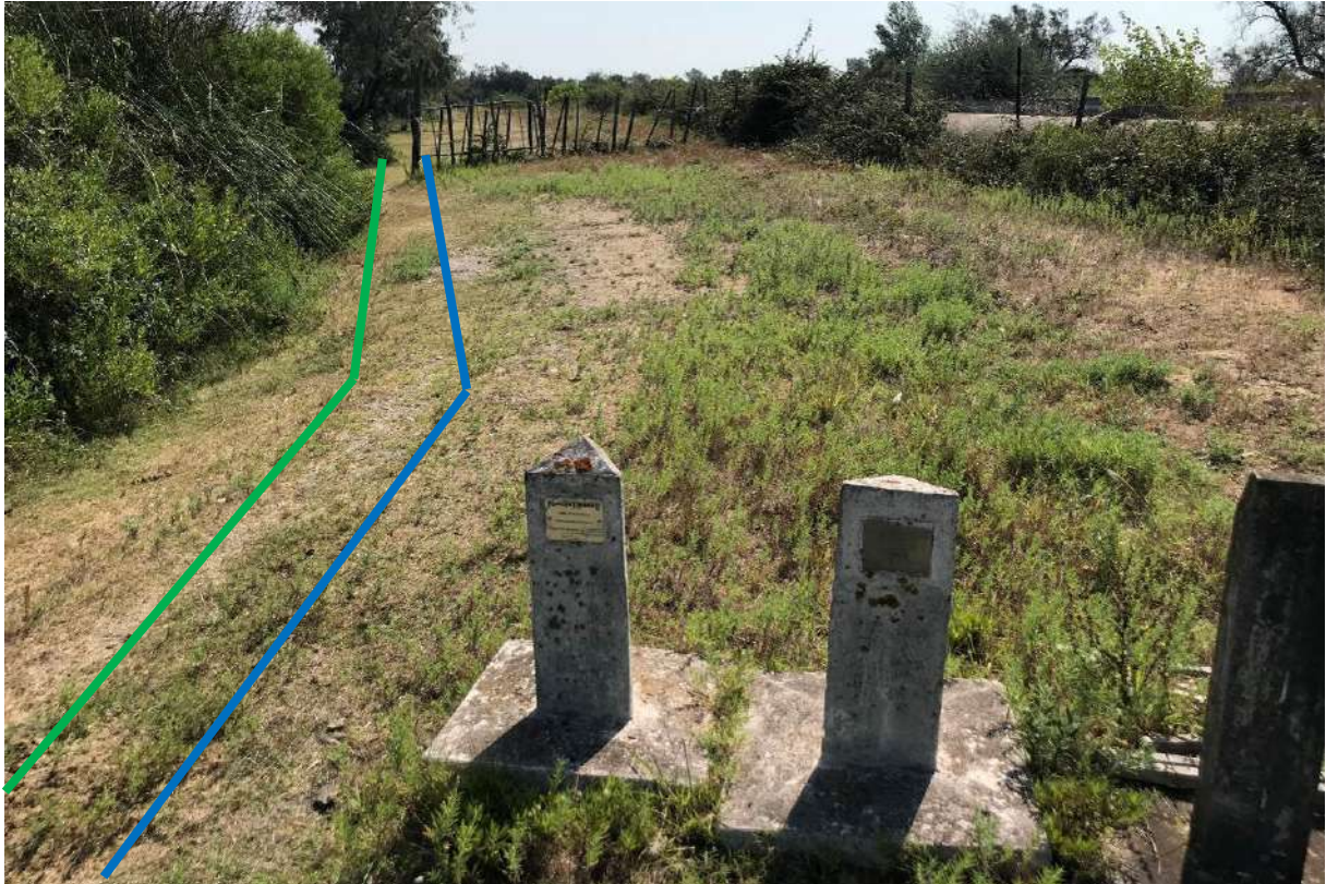
Photo 16 : Pose en tranchée dans une zone étroite
