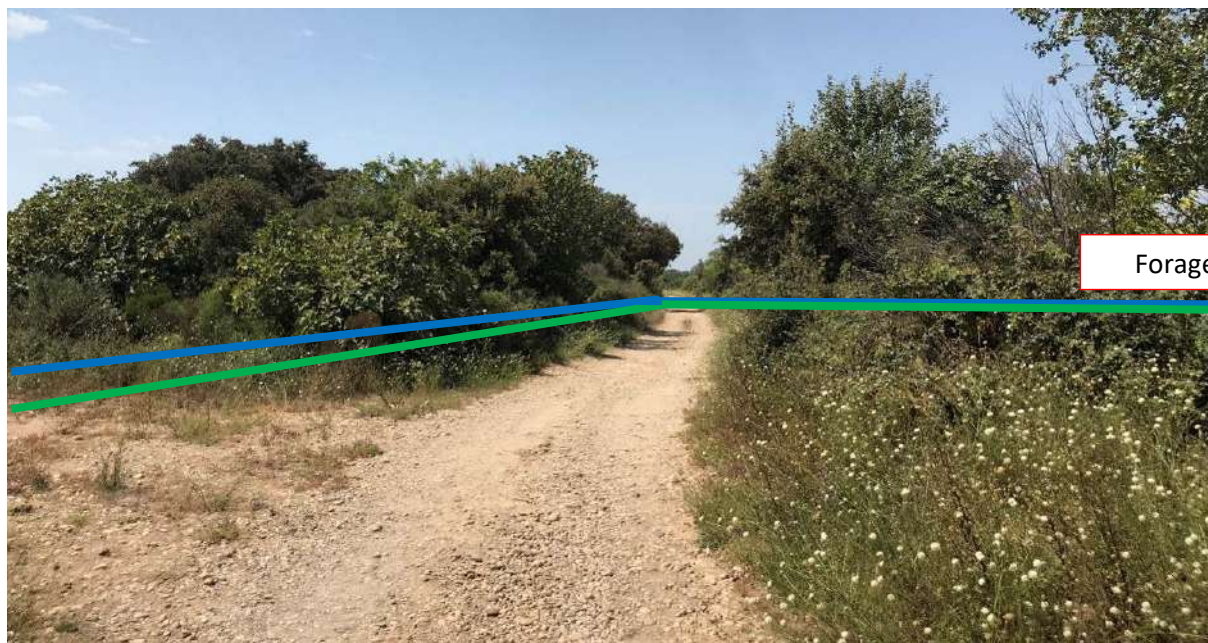
Photo 31 : Pose en tranchée sous le chemin
