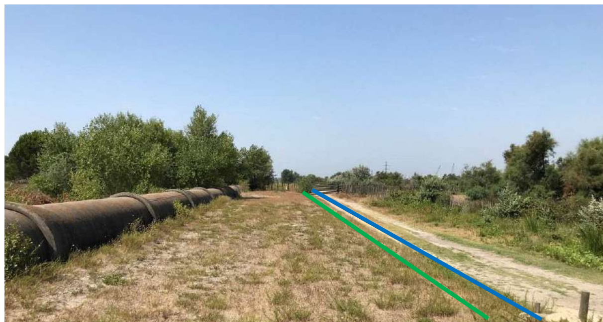
Photo 13 : Pose en tranchée dans la nappe du GPMM (ferme)
