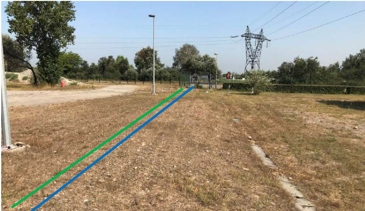
Photo 8 : Pose en tranchée en parallèle des réseaux existants (O2 et H2) jusqu'à la sortie de l'usine du Tonkin
