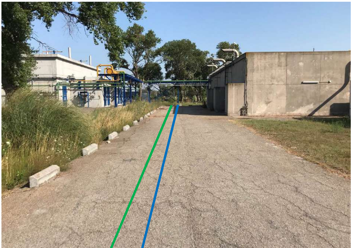
Photo 3 : Pose en tranchée sous voirie dans l'usine du Tonkin pour passer sous le rack
