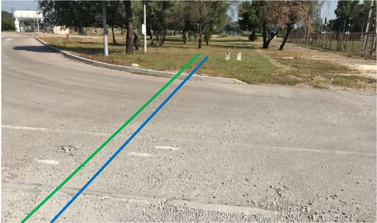
Photo 6 : Traversée à ciel ouvert d'une route interne en parallèle des réseaux existants
