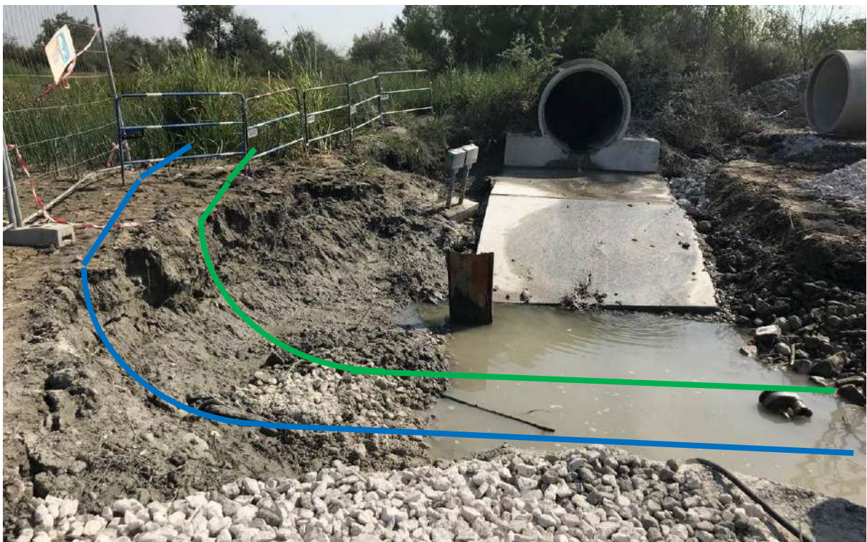
Photo 11 : Traversée des conduites du GPM
