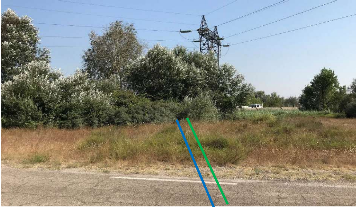
Photo 10 : Pose en tranchée en parallèle des réseaux existants (O2 et H2)
