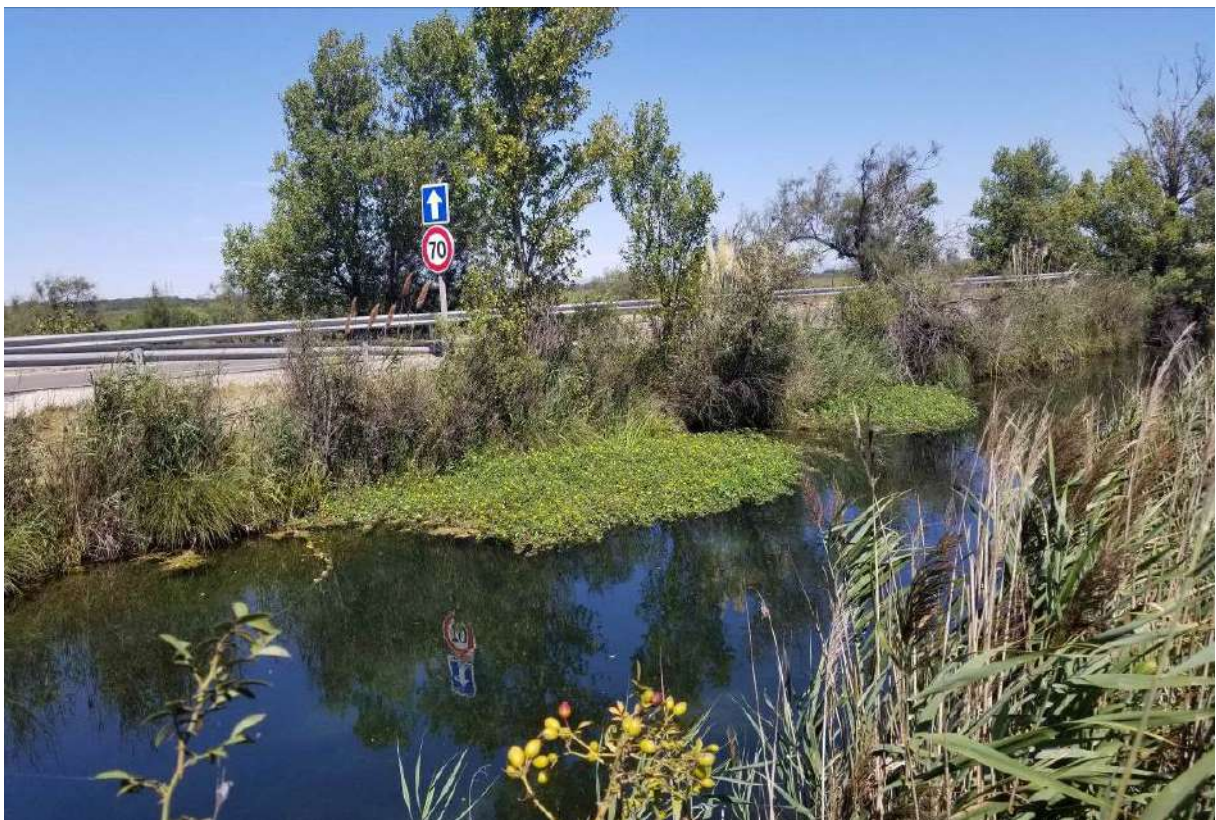
Photo 35 : Traversée de la route du port et la roubine
