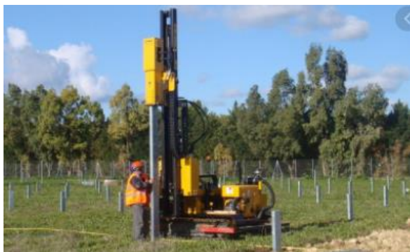
Figure 3. Ancrage des pieux battus
