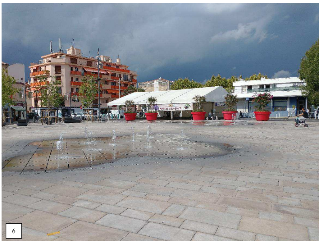
Photo 6 : Vue du sud de la Place Roubaud après la première phase de travaux et de la poste (24 septembre 2020)
