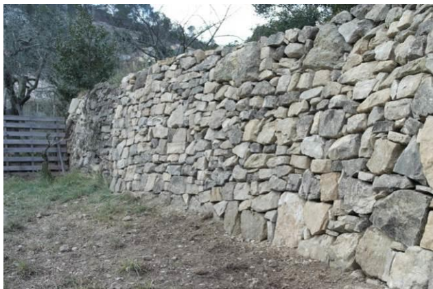
Murs de pierre sèche
