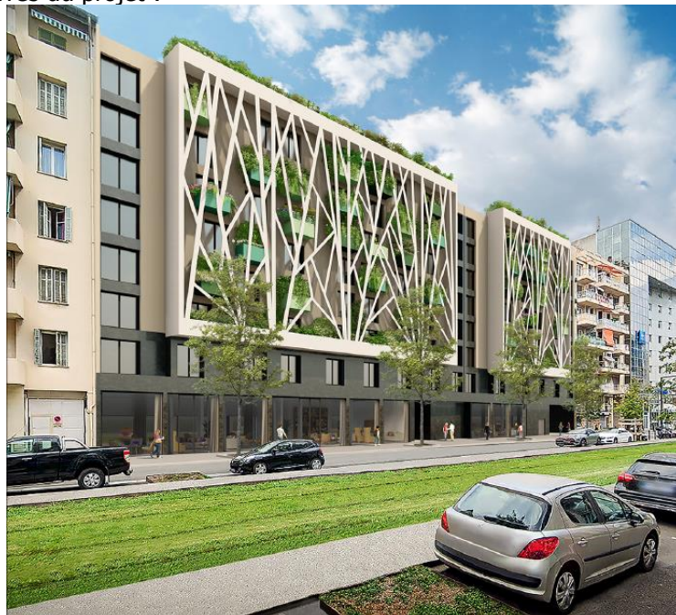
Vue depuis l'avenue de la Californie
