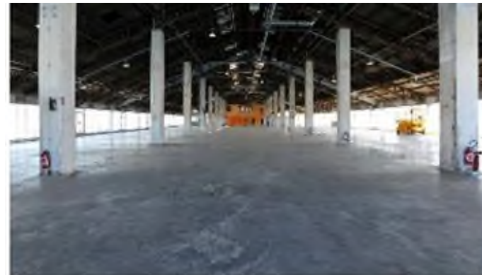
Photographie 16 – Vue du plateau R+2 (source : ADIM Provence)
