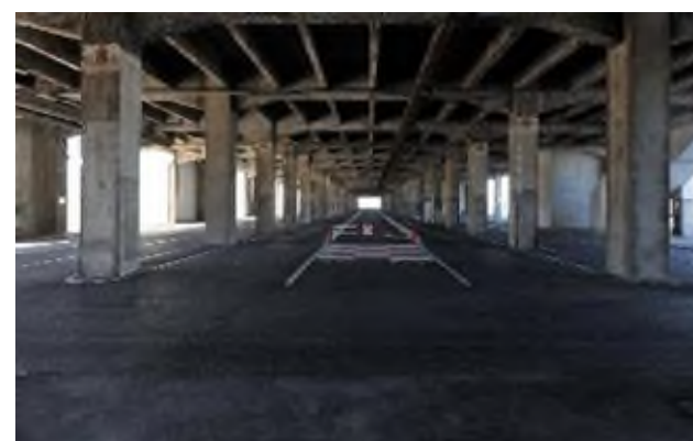
Photographie 11 – Plateau du rez-de-chaussée (vue vers l'Ouest) (source : ADIM Provence)
