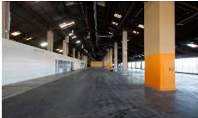
Photographie 15 – Vue du plateau R+2 (source : ADIM Provence)
