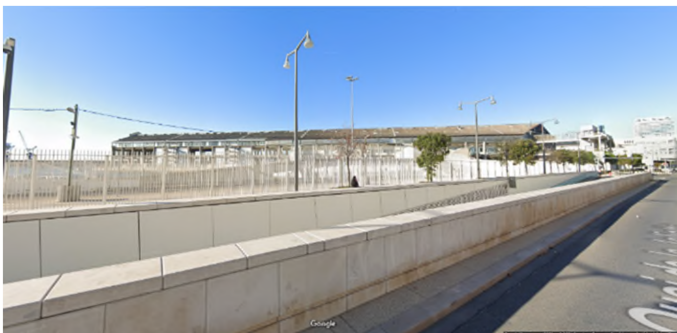
Photographie 4 - Vue du J1 depuis le quai de la Joliette - date de prise de vue novembre 2020 (Google Streetview)
