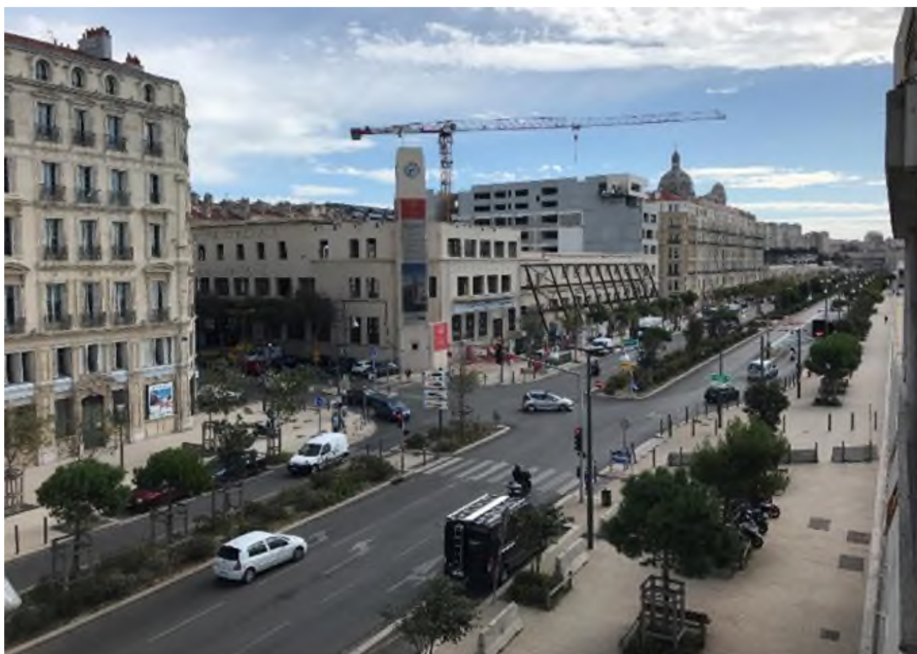
Photographie 8 – Vue depuis le J1 vers le Boulevard du Littoral Sud (source : ADIM Provence)
