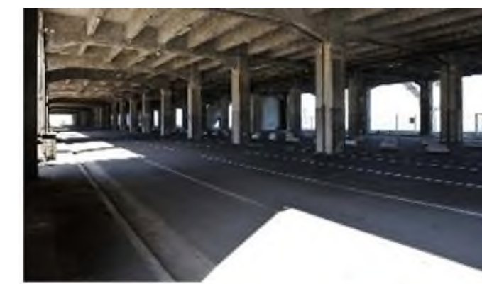
Photographie 12 – Plateau du rez-de-chaussée (vue vers le Nord-Ouest) (source : ADIM Provence)
