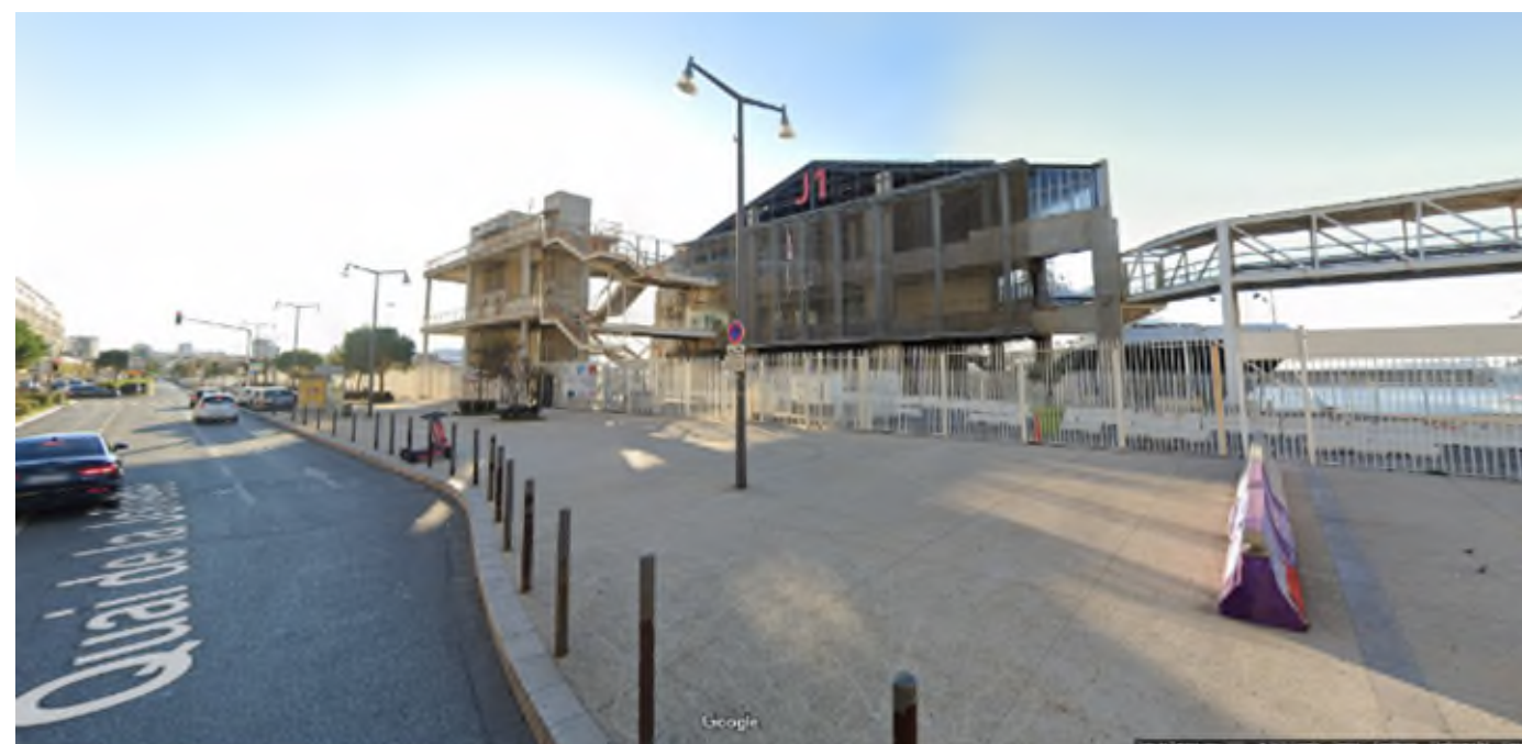
Photographie 6 - Vue du J1 depuis le quai de la Joliette - date de prise de vue novembre 2020 (Google Streetview)
