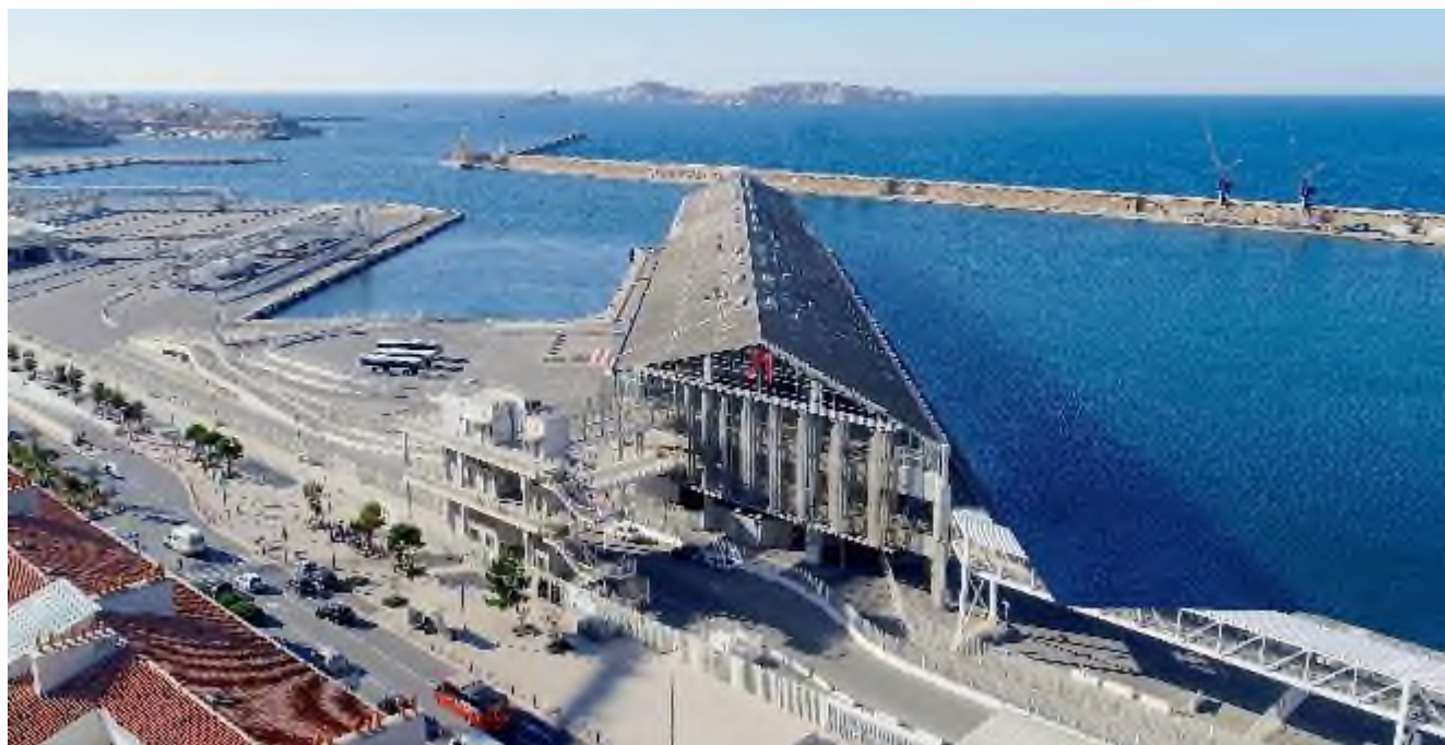
Photographie 3 – Vue aérienne de la façade Est du J1 existant (source : ADIM Provence)
