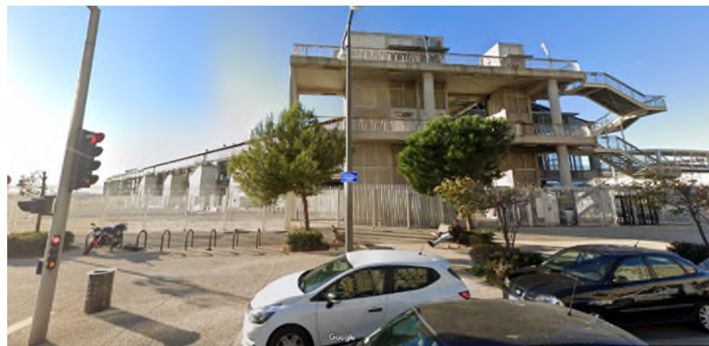
Photographie 5 - Vue du J1 depuis le quai de la Joliette - date de prise de vue novembre 2020 (Google Streetview)
