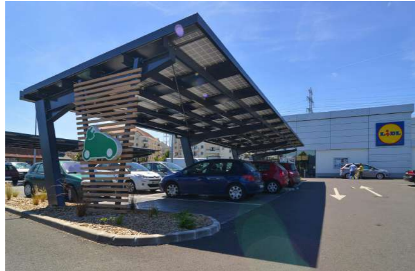
exemple ombrière photovoltaïque
